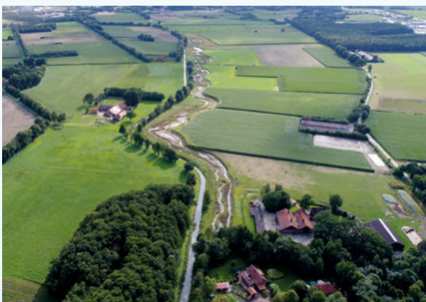
Die neue Flusstalau des Löninger Mühlenbaches
