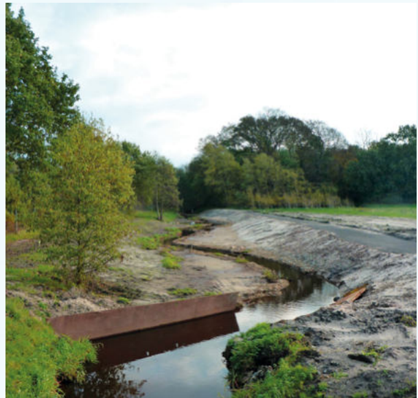
Laher Graben nach der Umsetzung
