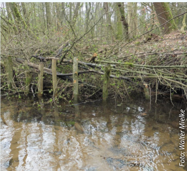
Totholzbunnen befestigen das Ufer und bieten Unterstände für Fischfauna
