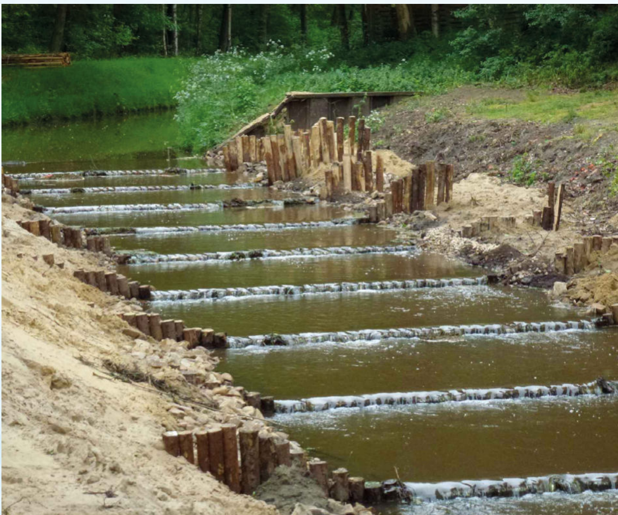
Bau der Einzelbecken
