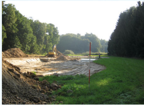
Während der Baumaßnahme
