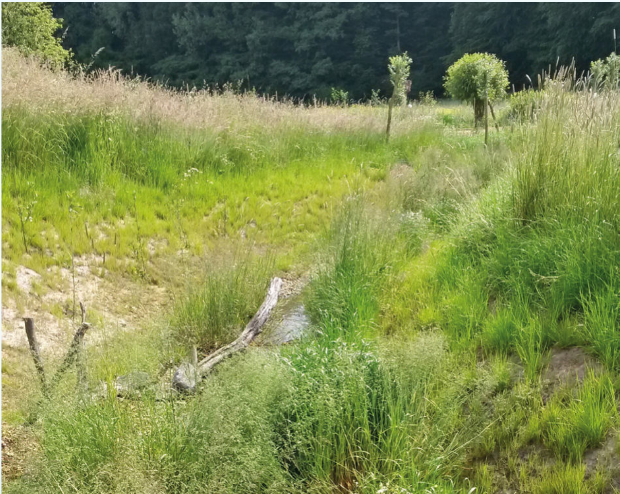
Der Borgloher Bach oberhalb des Rohrdurchlasses
