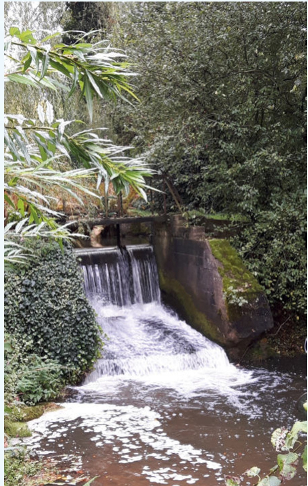
Altes Staubauwerk vor der Maßnahmeumsetzung
