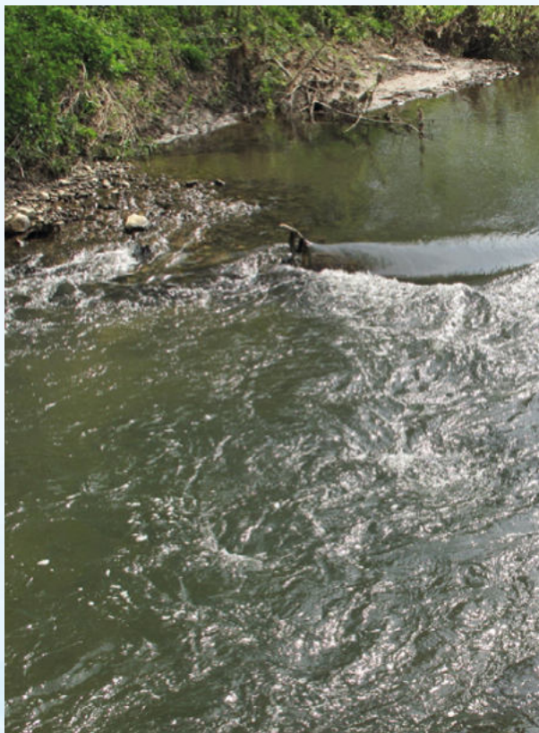
Einbau von Totholz
