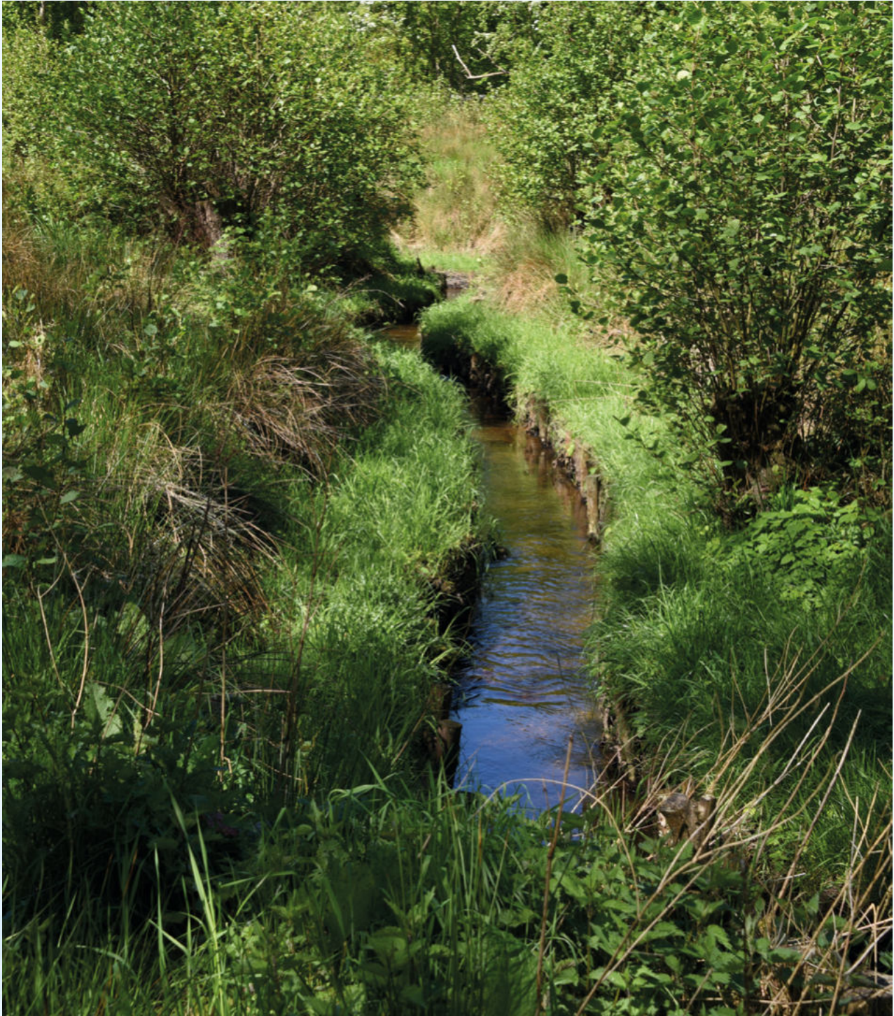
Faschinenwalzen befestigen vorübergehend das Ufer
