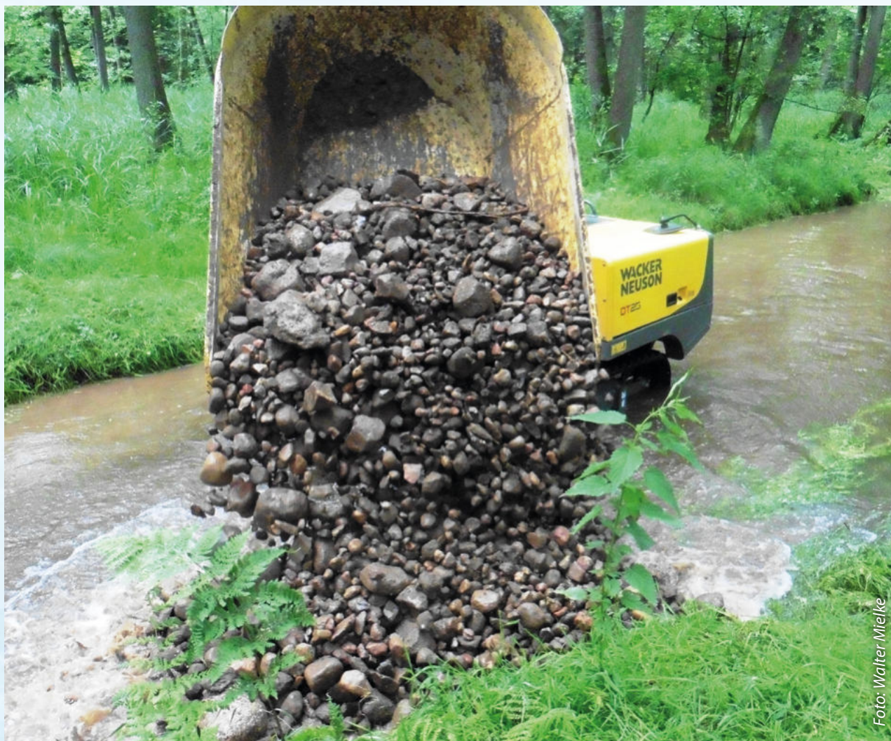
Der Dumper bringt Steine ins Gewässer
