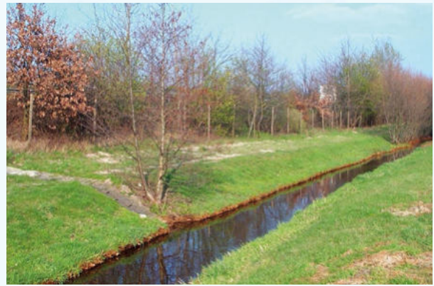
Laher Graben vor der Maßnahme
