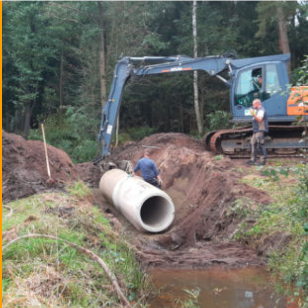
Durchlasserhöhung aufgrund erhöhter Sohlenlagen
