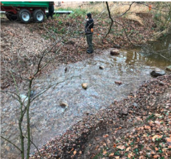
Einbau von Störsteinen Bild linke Seite: Strömungslenker aus Totholz
