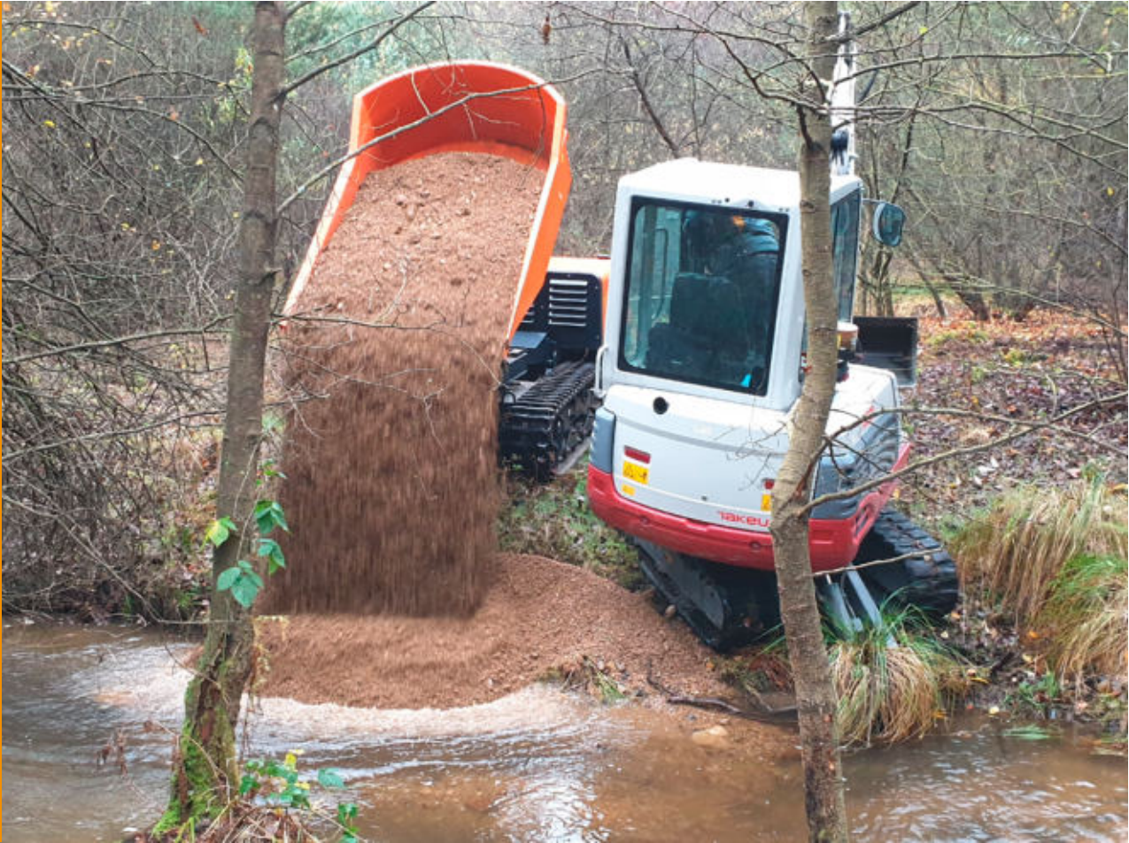
Einbau von Kies mit Dumper und Minibagger
