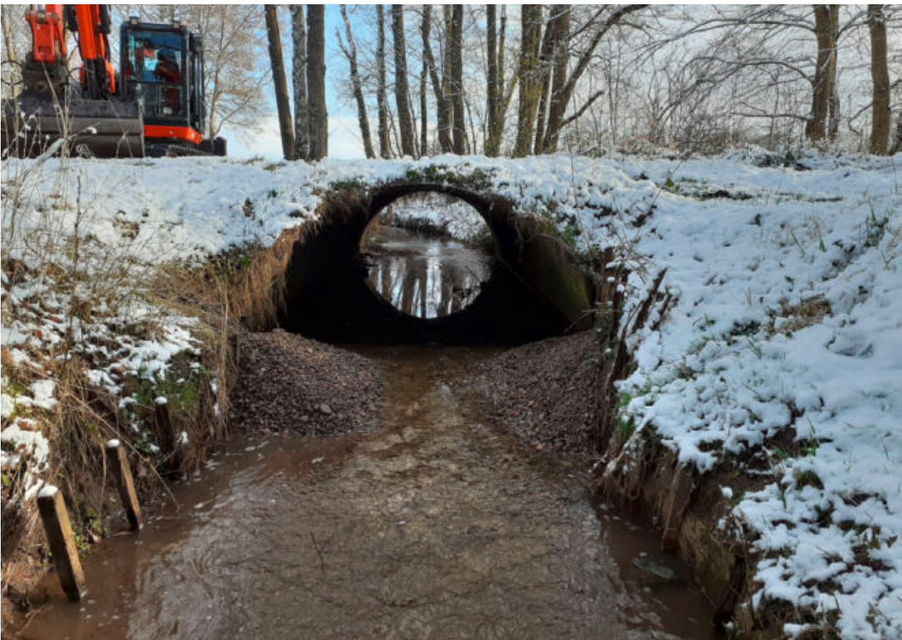
Kiesaufschüttung im Unterwasser zur Beseitigung von Sohlabstürzen
