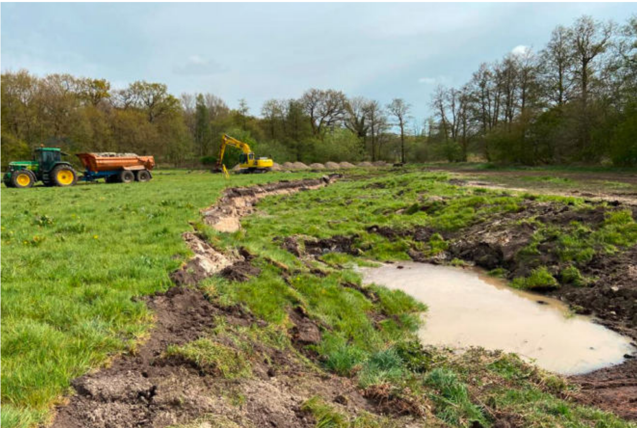
Ausmodellierung der Seitengewässer mit verschiedenen Gewässertiefen Bild linke Seite: Neu hergestelltes Seitengewässer mit großen Flachwasserbereichen
