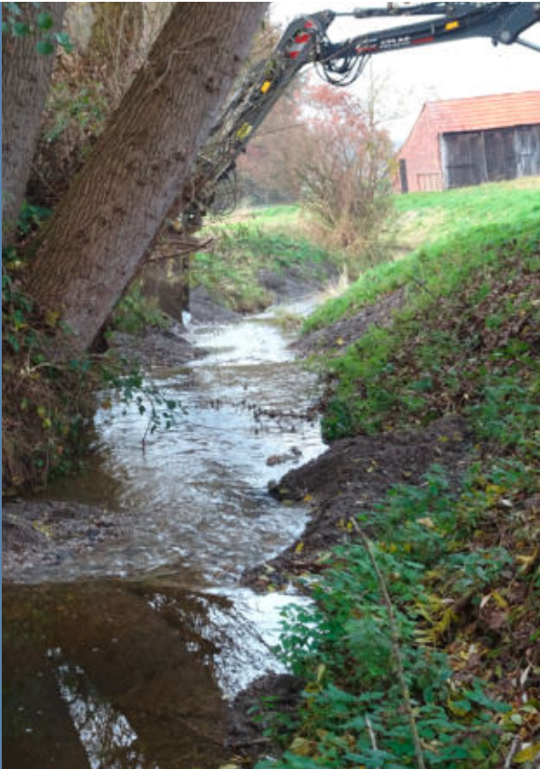
Anlage von Laichbetten im Elsbach Bild linke Seite: Großflächiger Einbau von Kies als Depot für eine natürliche Eigenentwicklung
