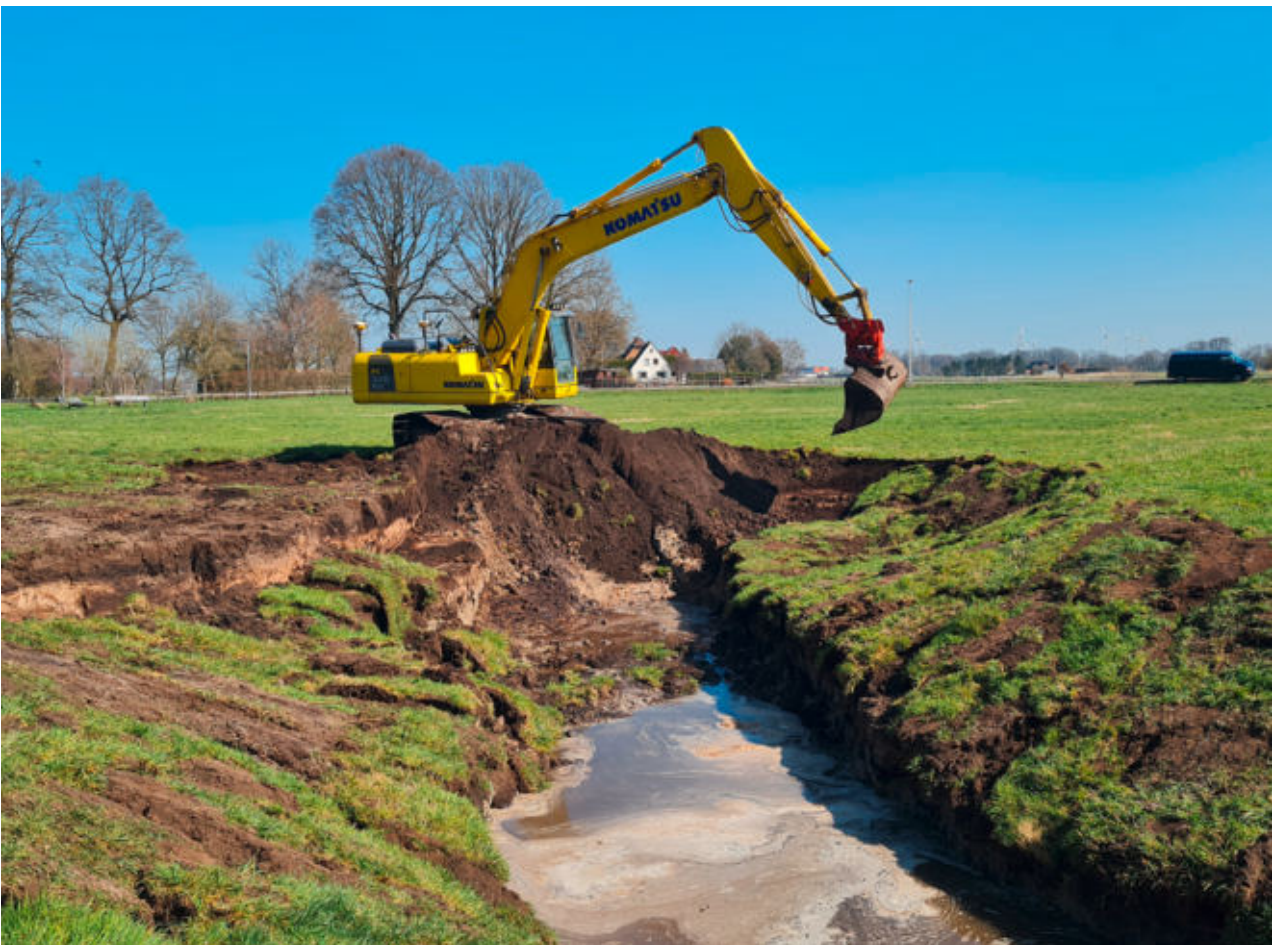
Die Ufer werden mit anstehenden Grassoden abgedeckt, um das Aufkommen von Gehölzen zu verzögern Bild linke Seite: Unterstromig angebundener Altarm in der Ortslage Grasberg
