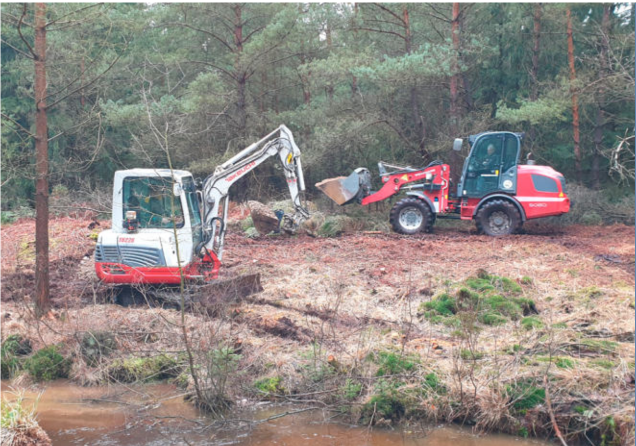
Arbeitsteilung zwischen Radlader und Minibagger Bild linke Seite: Strömungs- und Substratdiversität nach Kieseinbau
