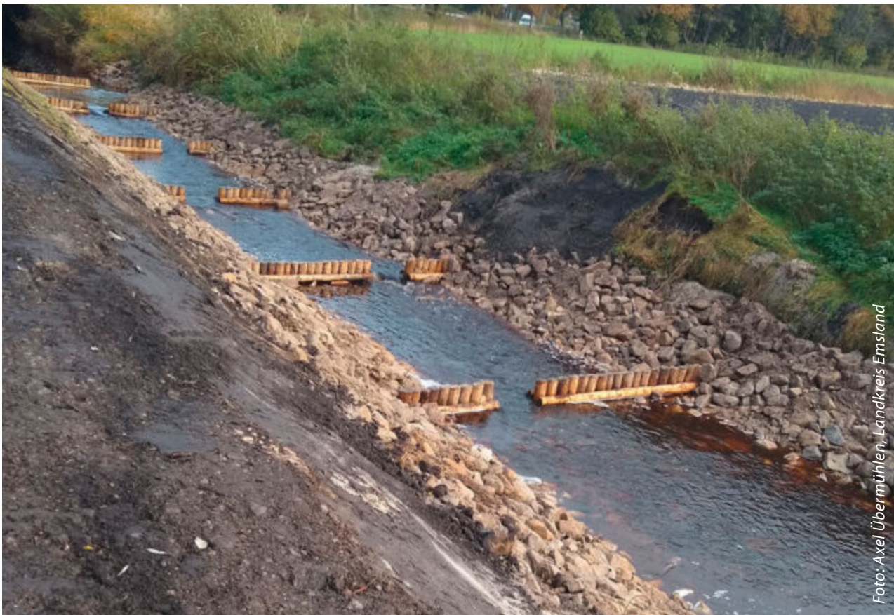
Sohlgleite in Riegel-Beckenbauweise kurz nach Fertigstellung Bild linke Seite: Abzweig zum neuen Nebengerinne
