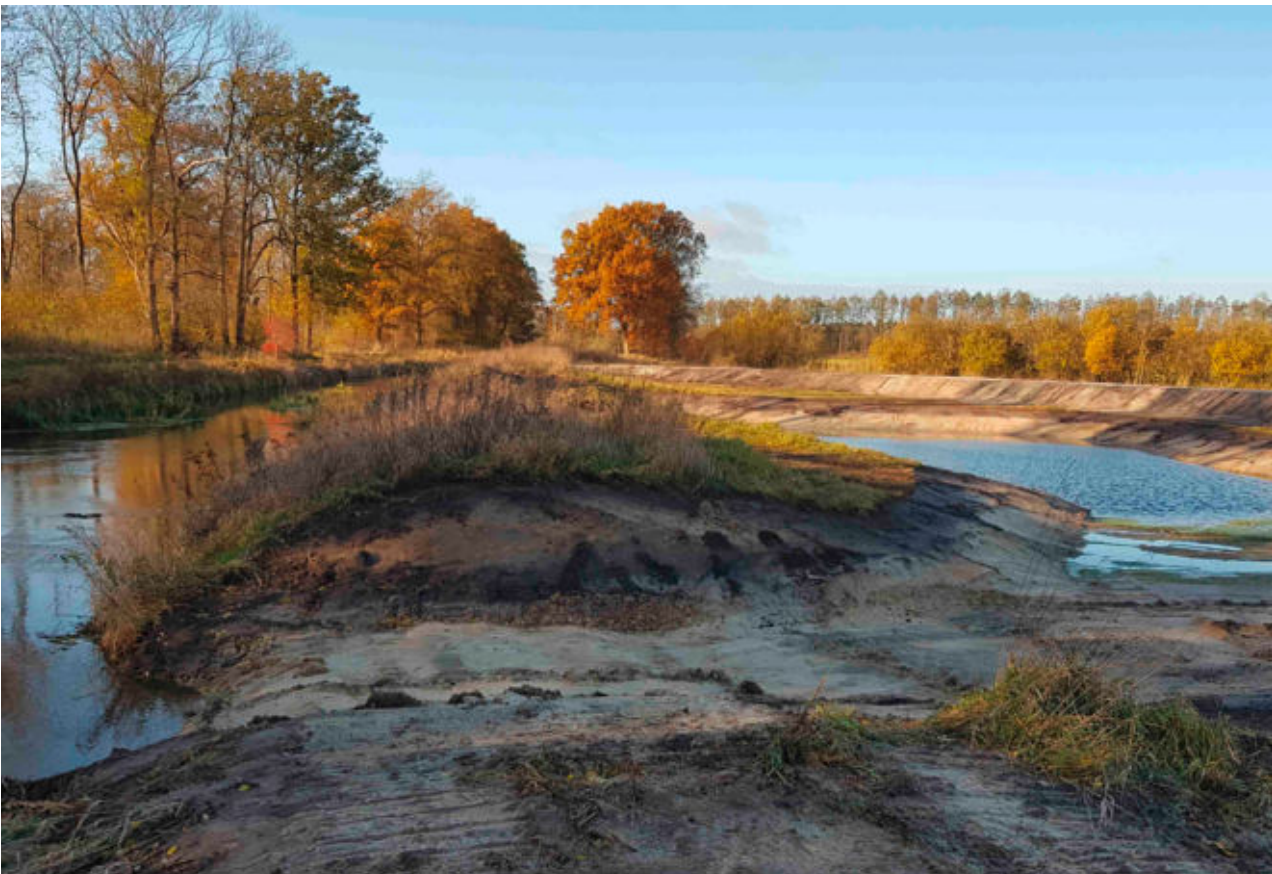
Neu geschaffener „Altarm“ mit Überlaufschwelle im Drömling kurz nach Fertigstellung Bild linke Seite: Neu entstandener „Altarm“
