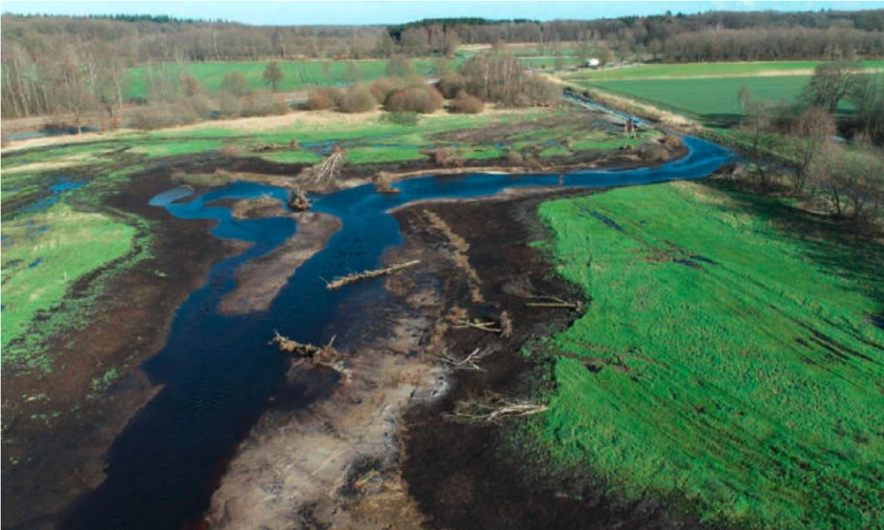
Geringe, dem natürlichen Vorbild entsprechende Eintiefung des neuen Gerinnes ermöglicht die Entwicklung einer amphibischen Auenlandschaft
