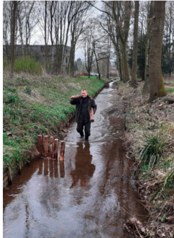
Einbau von Stützelementen zur Einengung einer strömungsgeprägten Niedrigwasserrinne
