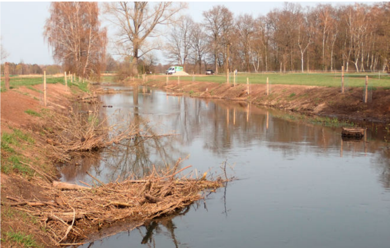
Böschungsbepflanzungen und Rauchholzbunnen schaffen Strukturvielfalt Bild linke Seite: Ein Jahr nach Umsetzung zeigt sich der volle Umfang der Strukturverbesserung
