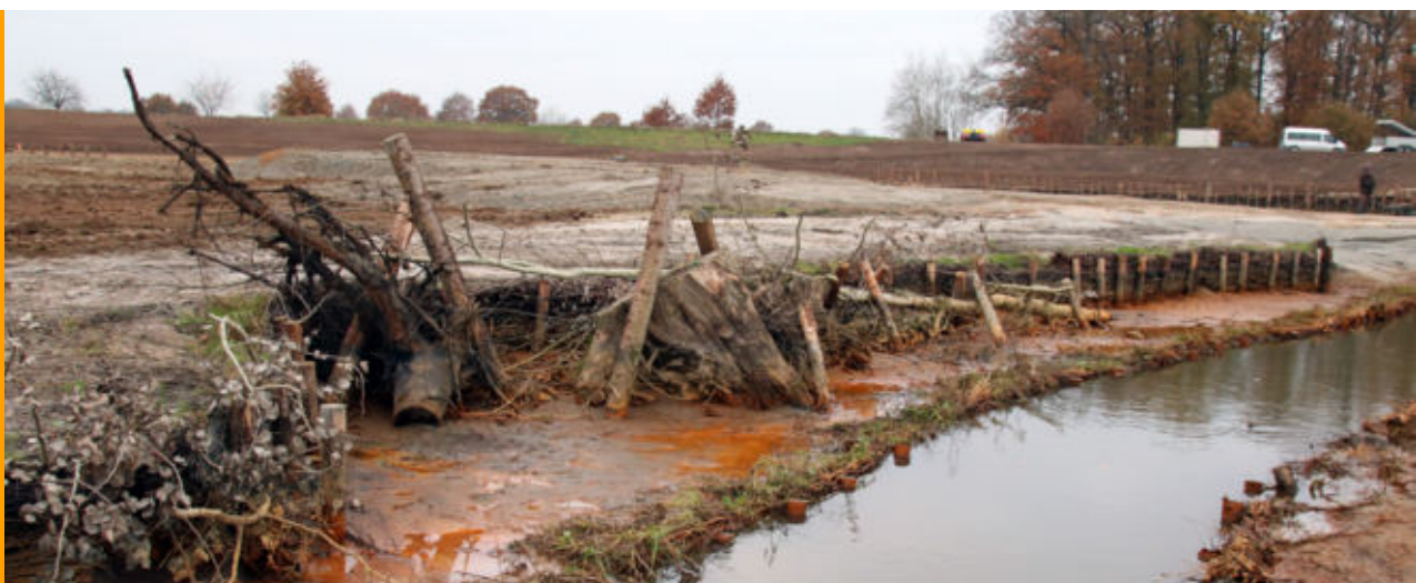
Totholzeinbau im Bereich der Mittelwasserlinie bei sehr niedrigem Wasserstand
