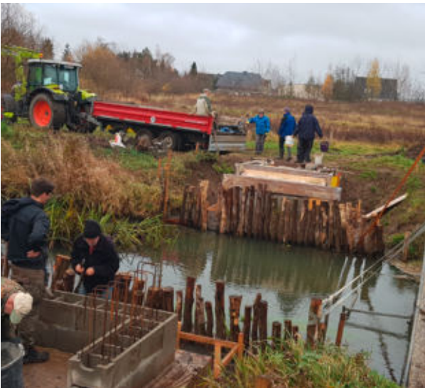
Neubau Rindersteg zu Beginn
