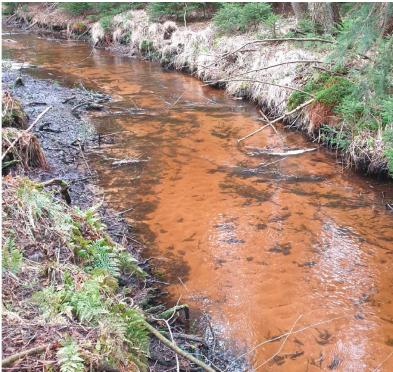
Vor Beginn der Maßnahme - monotone Sandablagerungen dominieren die Bachsohle
