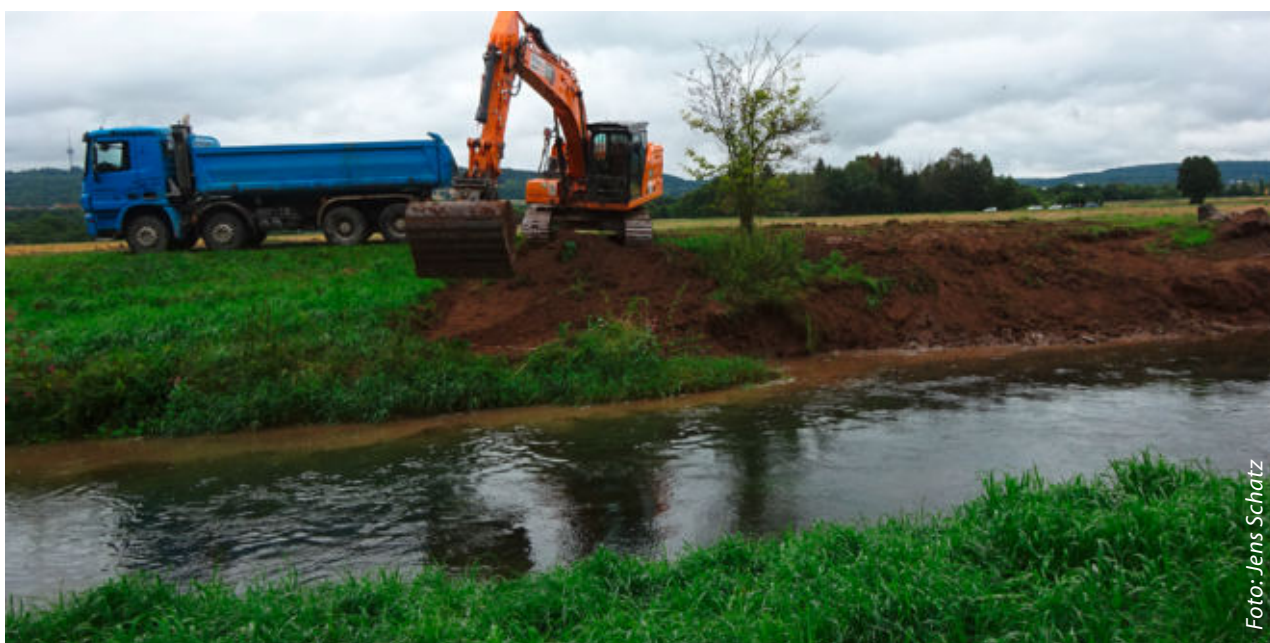
Die Entfernung alter Wasserbausteine ermöglicht wieder eigendynamische Gewässerentwicklung Bild linke Seite: Rauschen und durchströmte Seitenarme schaffen wieder ein naturnahes Habitatmosaik
