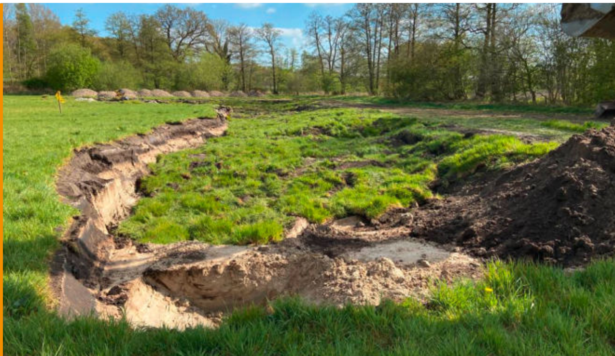
Der Einbau von direkt vor Ort gewonnen Grassoden gewährt eine standortgerechte Vegetationsentwicklung
