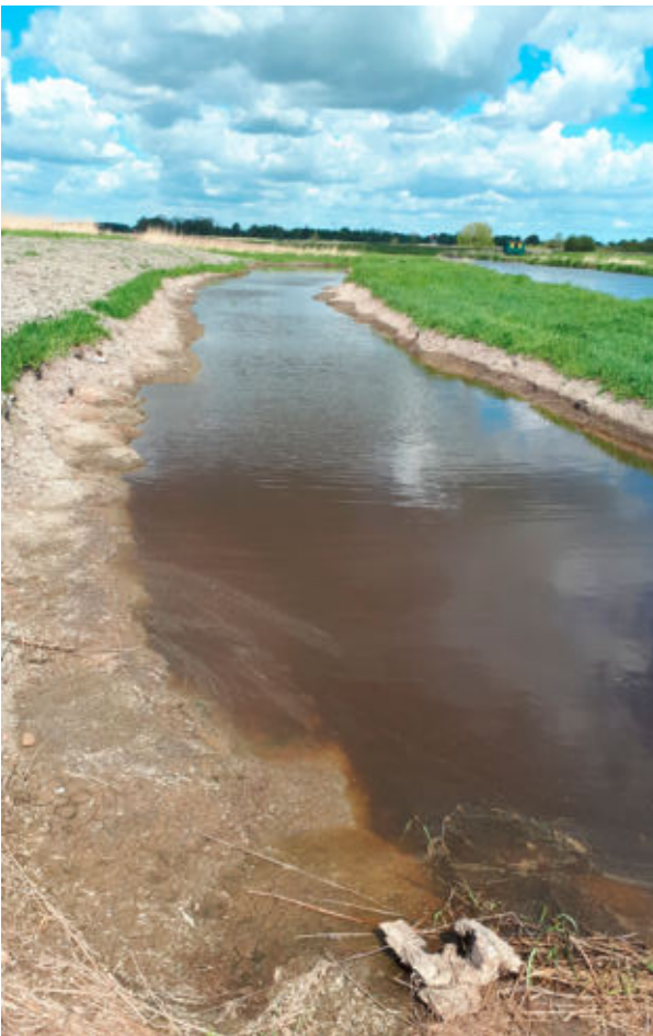
Das neue Laichareal an der Jade kurz nach Fertigstellung. Jetzt fehlt nur noch das Aufwachsen der Vegetation unter und am Wasser für eine perfekte Kinderstube. Bild linke Seite: Der schwere Kleiboden macht schweres Baugerät erforderlich
