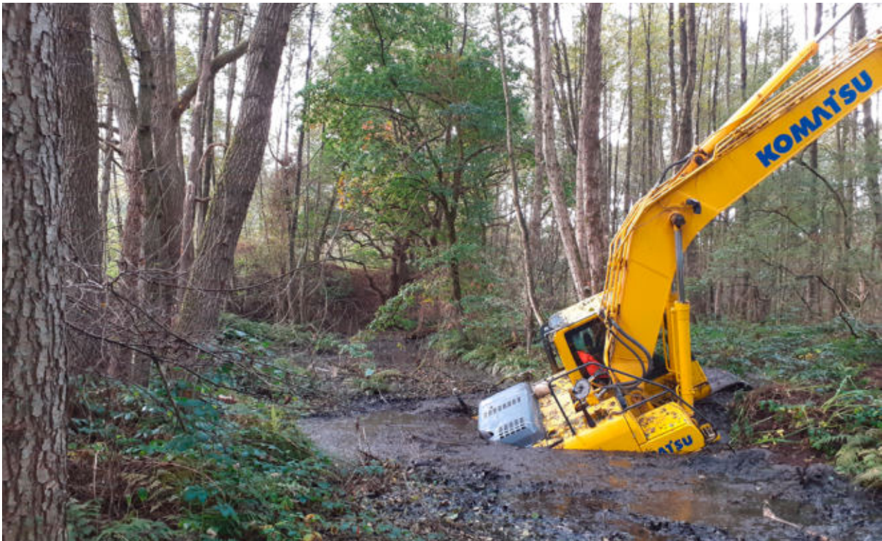
Arbeiten in schwerem Gelände
