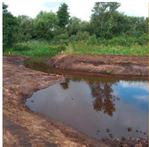
Unterstromige Anbindung der Blänke an die Wörpe kurz nach Fertigstellung
