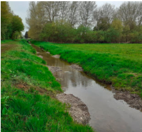
Strukturverbesserung durch den Einbau von Kiesbänken Bild linke Seite: Schüler*innen beim Einbau von Kiesbänken
