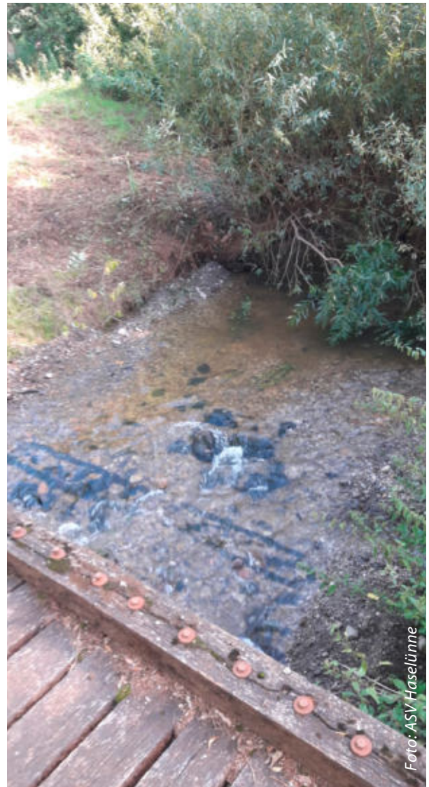
Sohlschwelle nach Kieseinbringung wieder durchgängig
