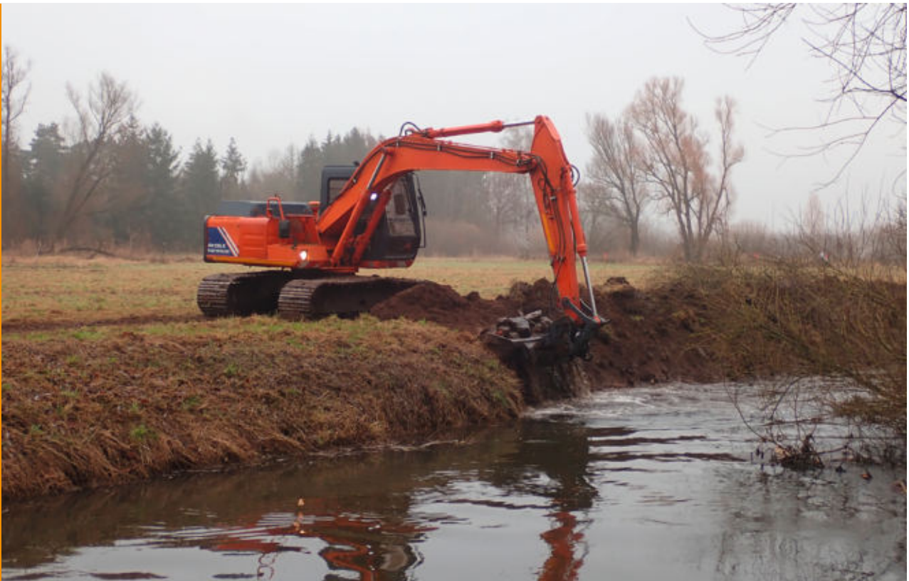
Entnahme von Wasserbausteinen
