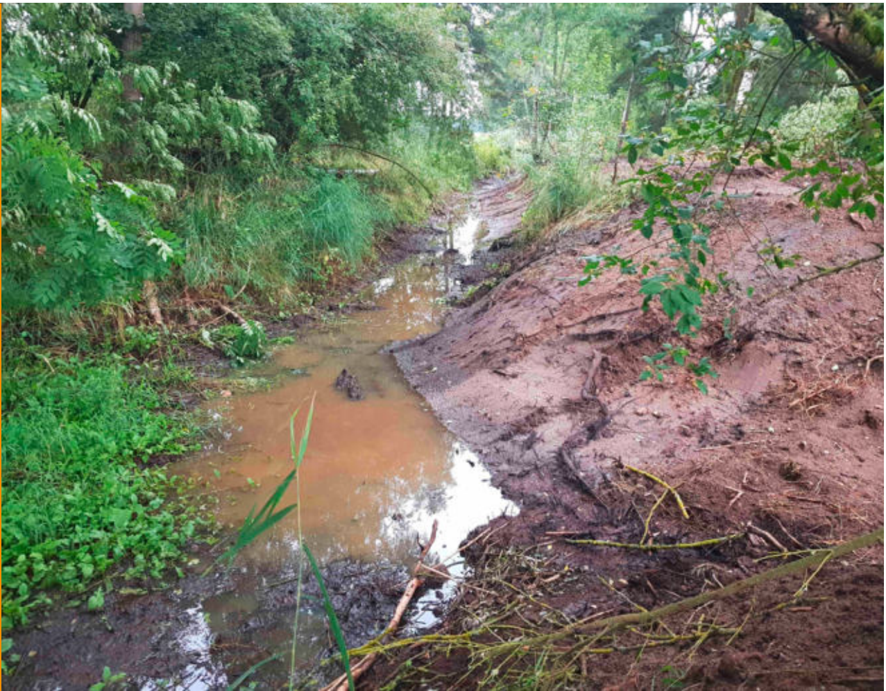
Anschluss eines Altarms über einen Entwässerungsgraben bei Niedrigwasser
