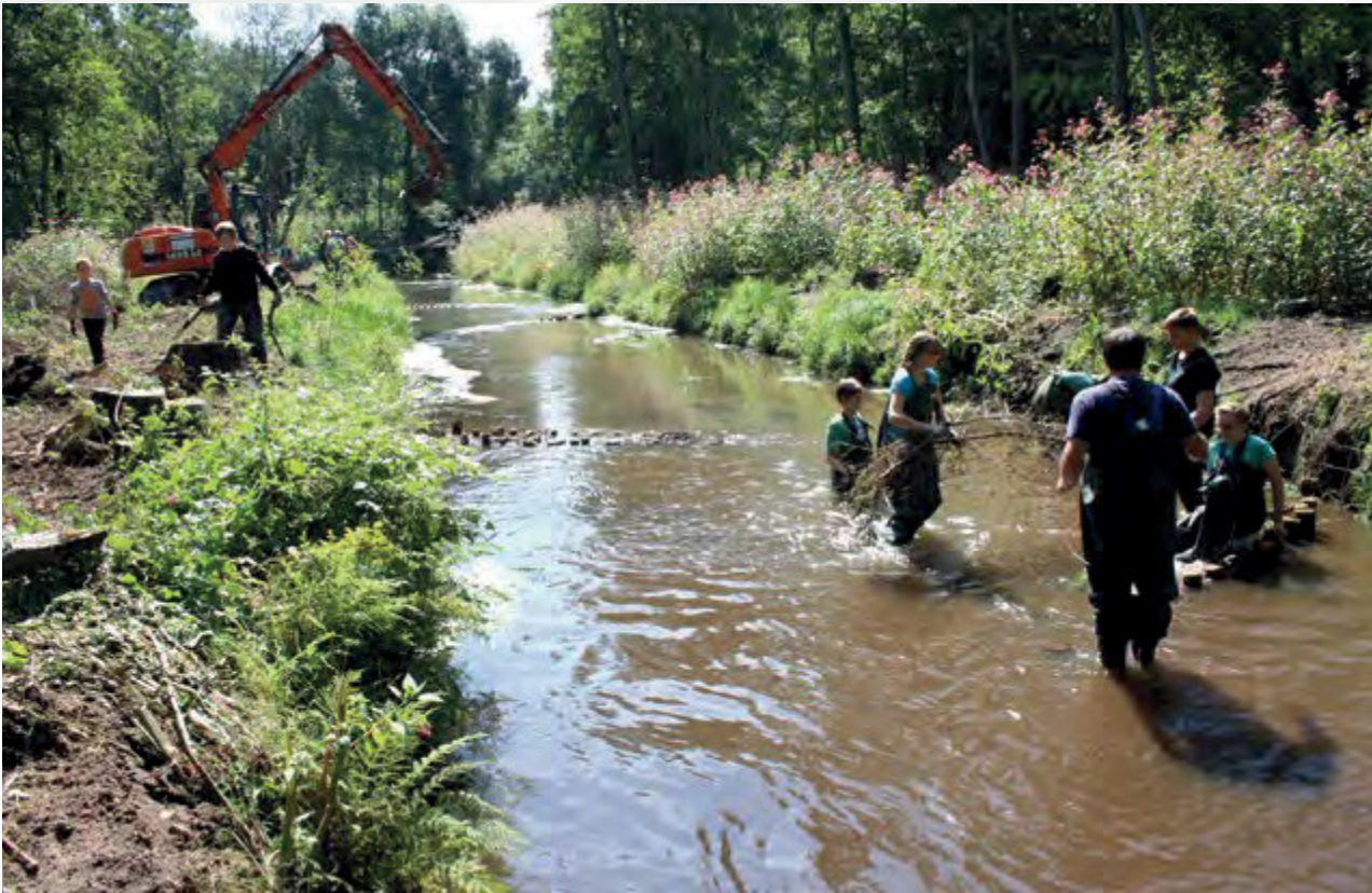
Einbringung von Strömungslenkern ...
