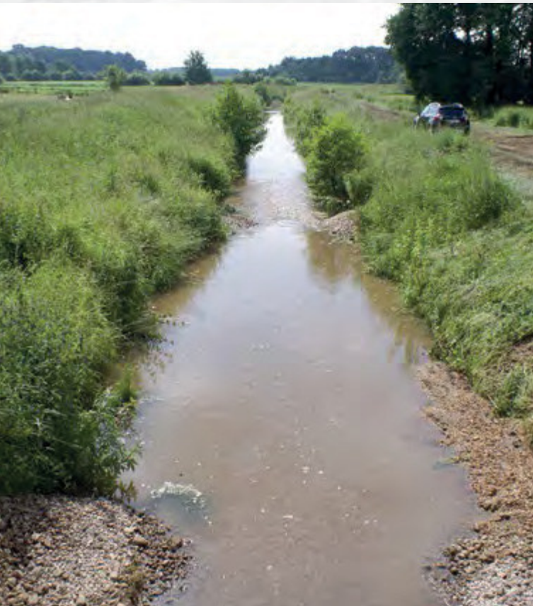
Kurz nach der Maßnahmenumsetzung ...
