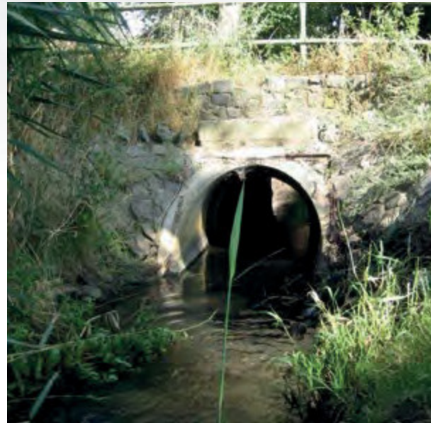
Einlauf in die Verrohrung nach der Umsetzung
