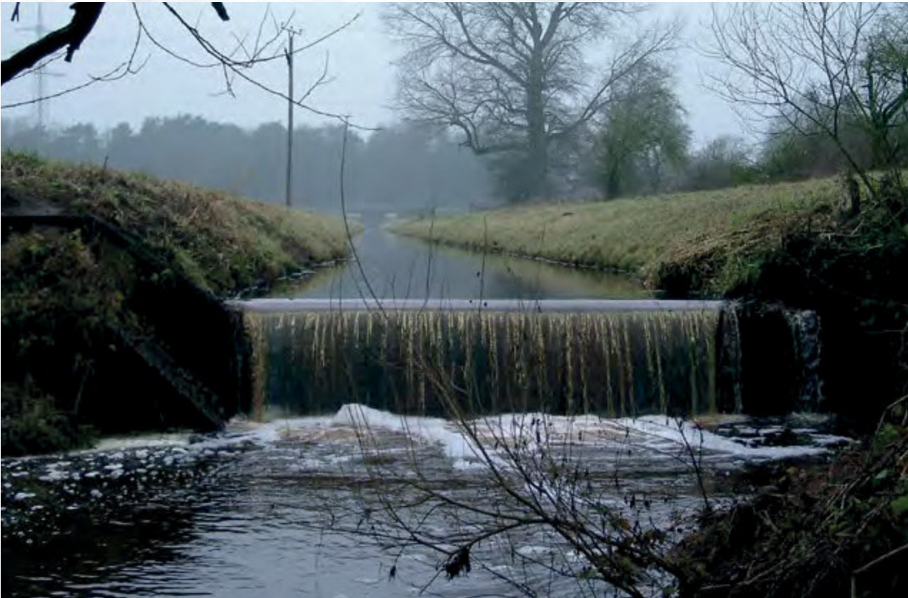
Sohlabsturz bei Hochwasser vorher
