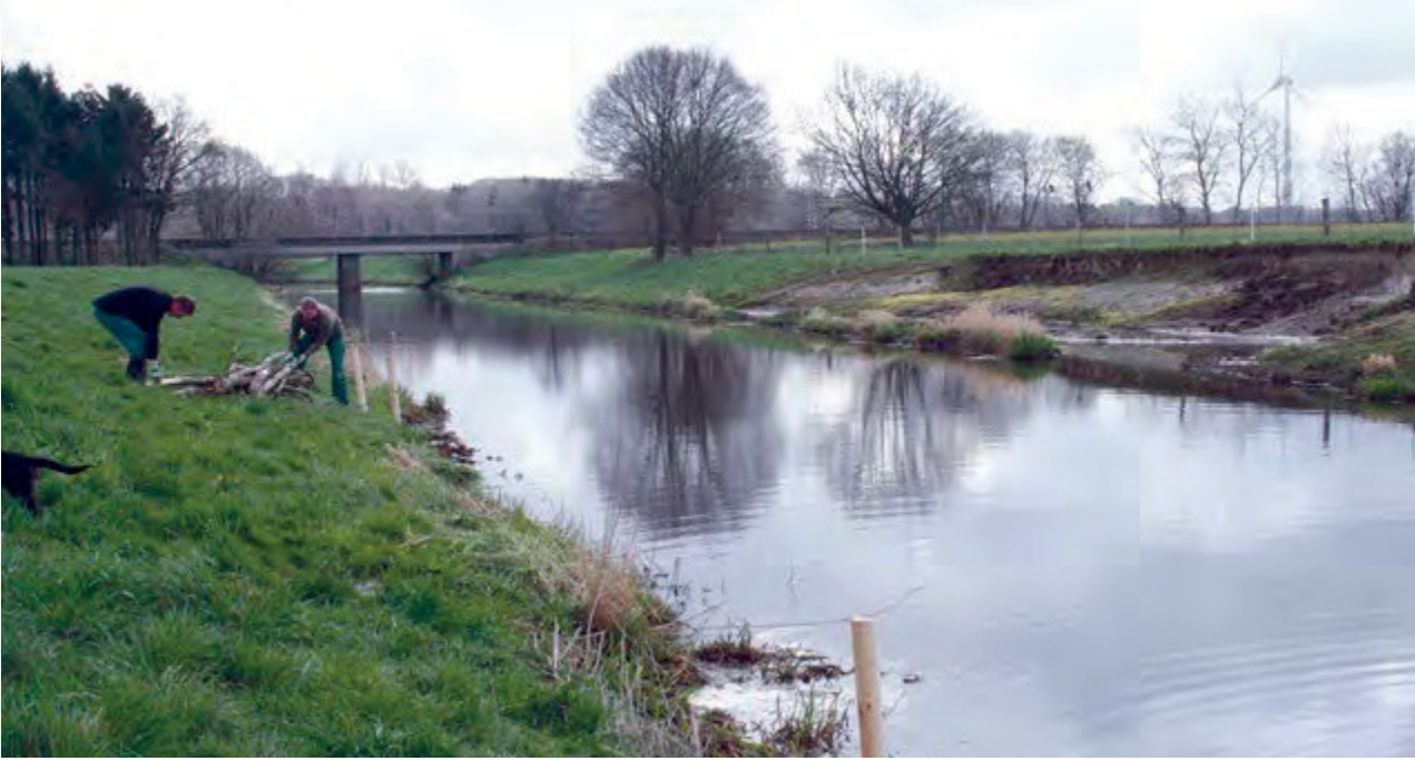
Totholzeinbau bei Cornau
