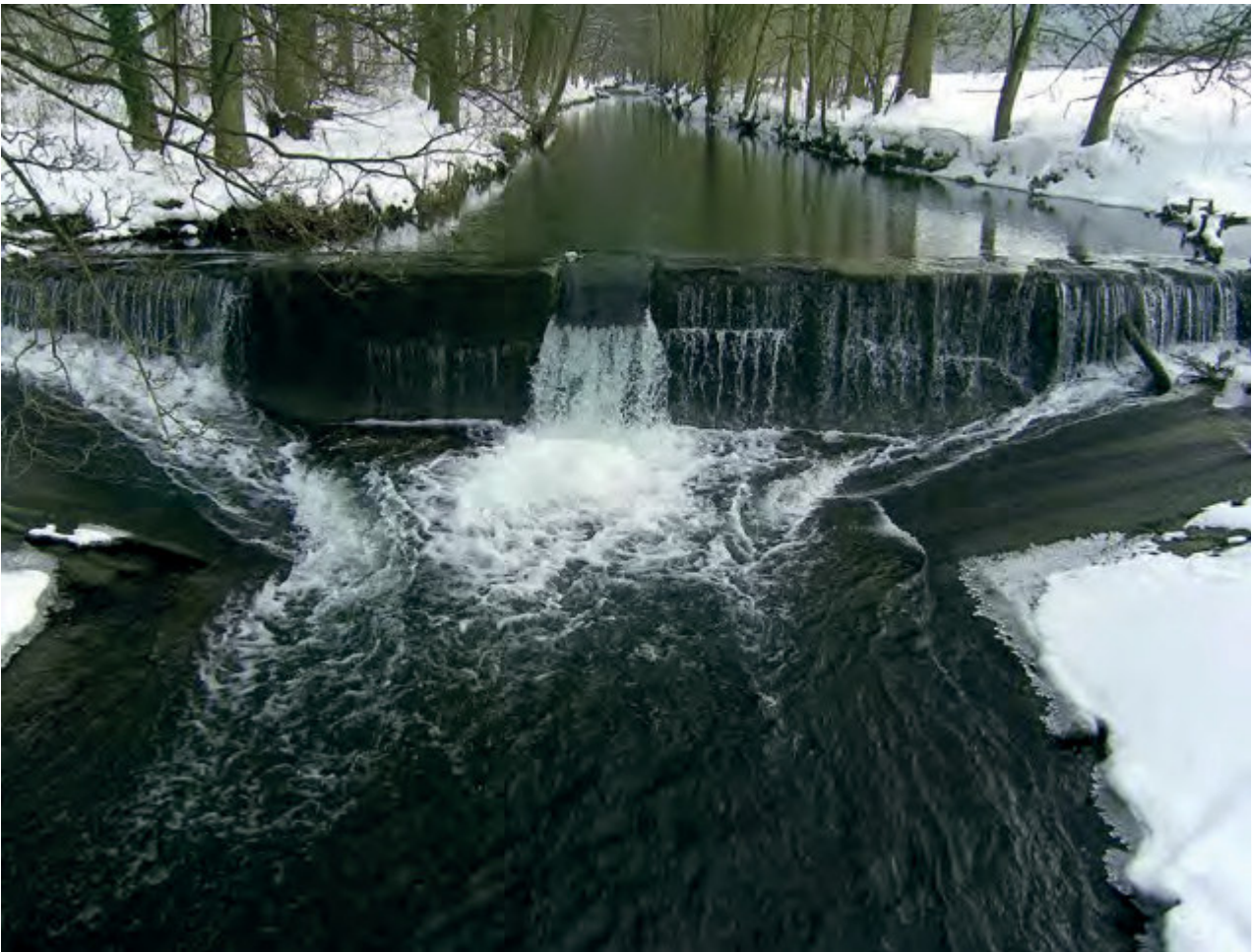
Der alte Zustand des Wehrs im Winter 2010
