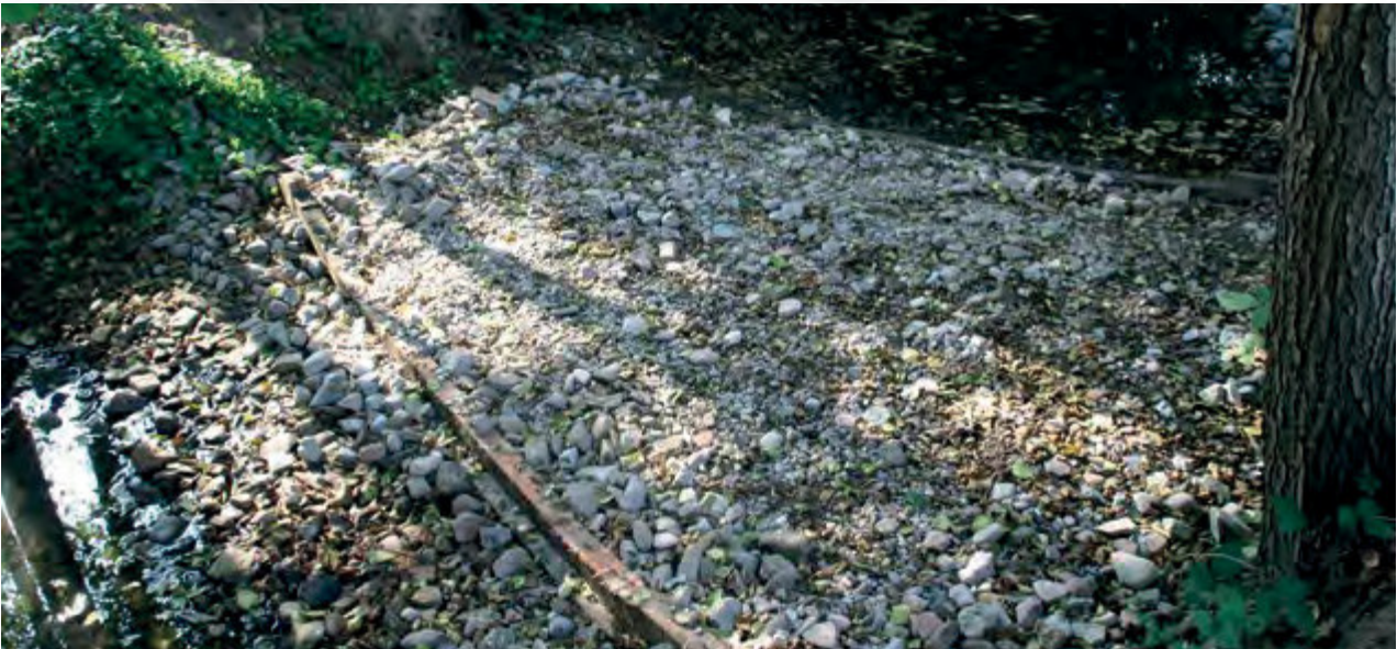
Überlaufschwelle zum Sandfang
