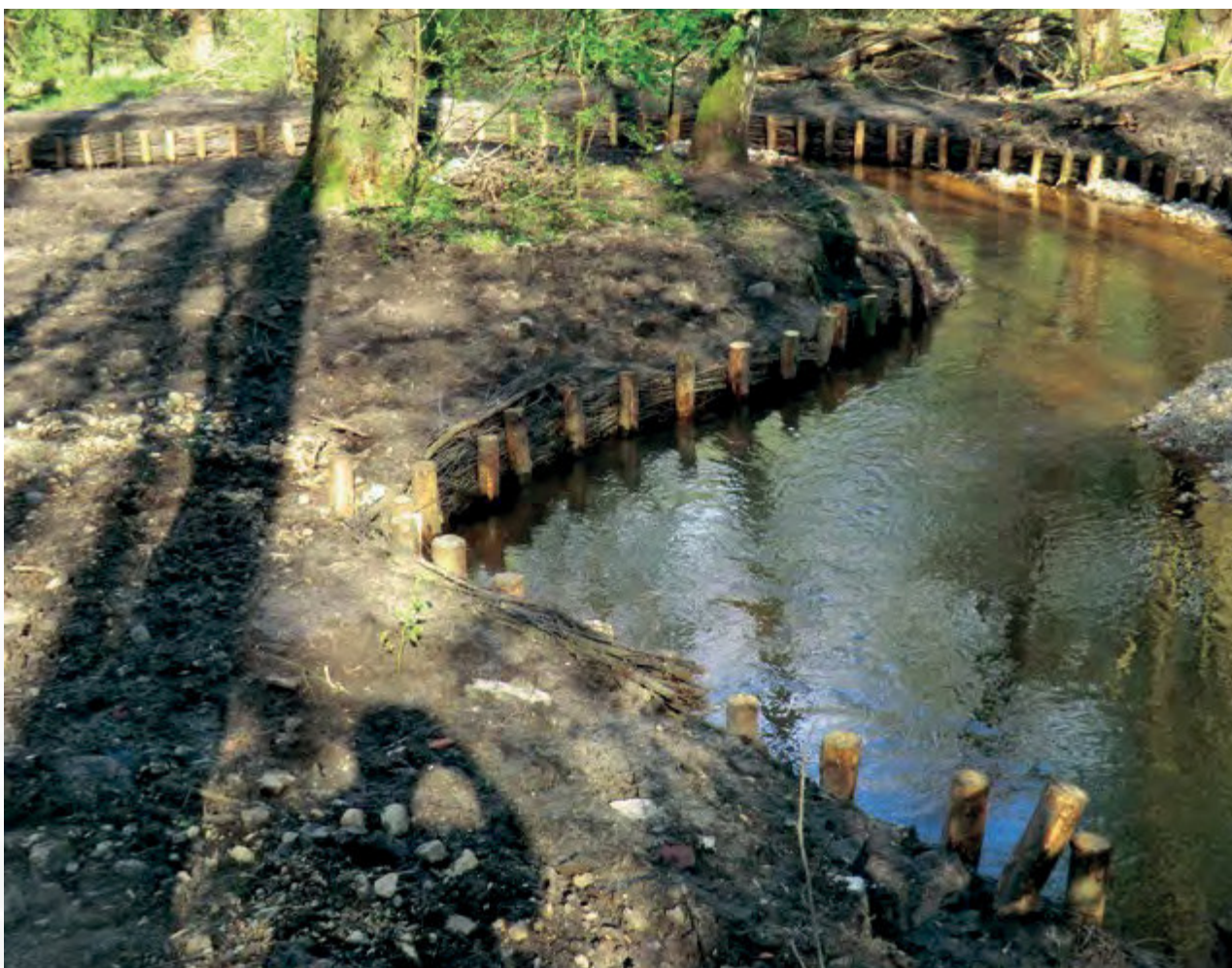
Nach der Umsetzung: temporär gesicherte Prallhänge im neuen Gewässerlauf bei der ehemaligen Wehranlage 2
