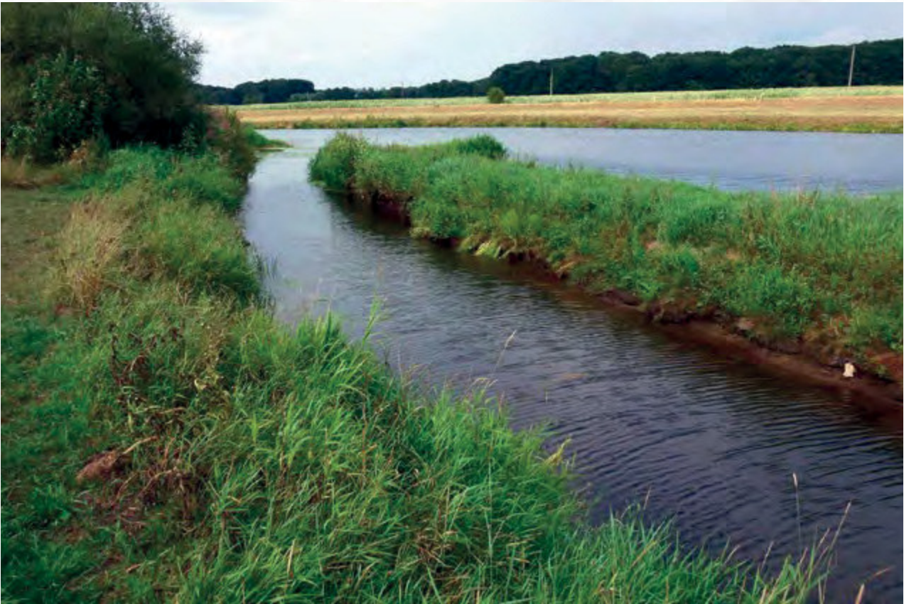
Angelegtes Seitengewässer 2 - ca. 5 Monate nach der Maßnahme
