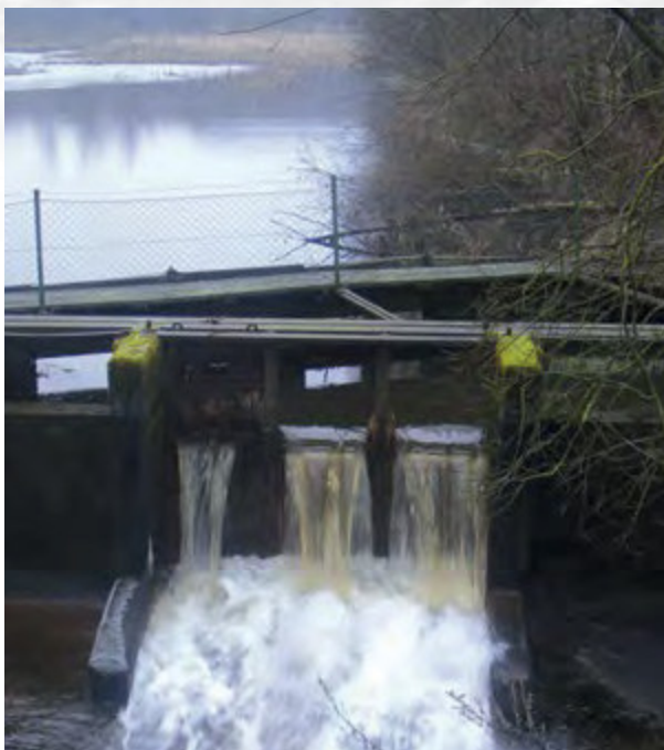
Altes Wehr am Lagerteich bei Beginn der Absenkung
