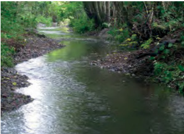
Abschnitt nach der Fertigstellung bei Niedrigwasser ...
