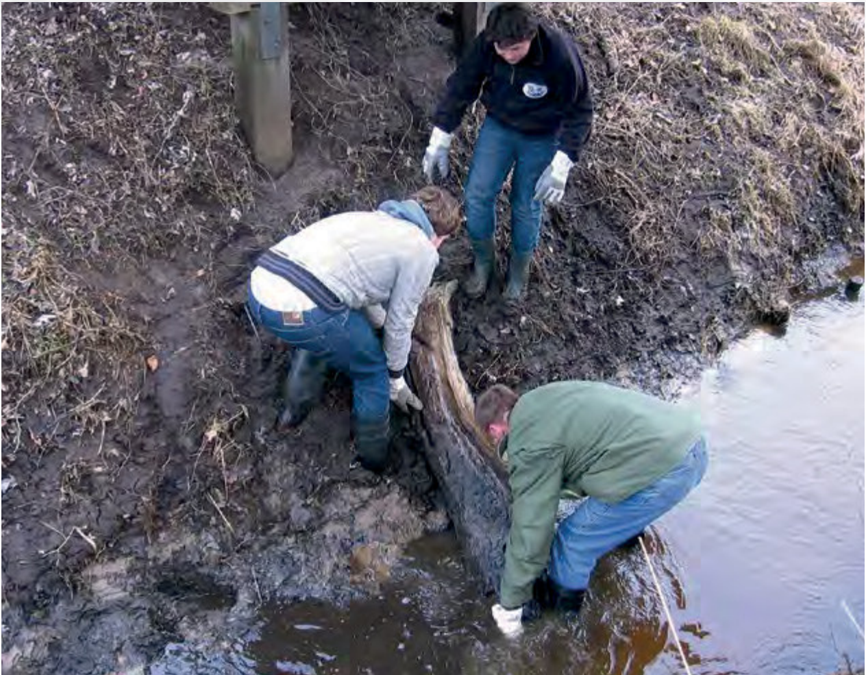
Totholzeinbau in der Böschung
