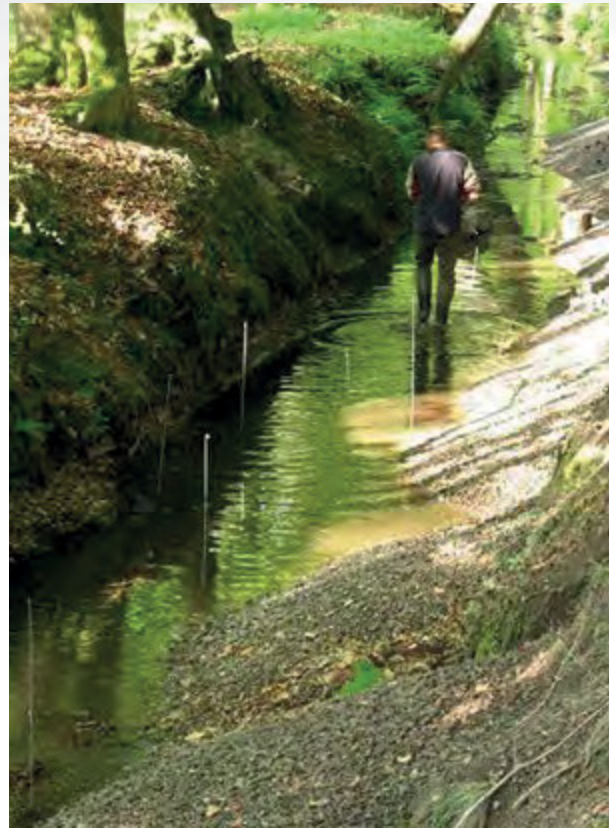
Schaffung eines schmalen Niedrigwasserprofils
