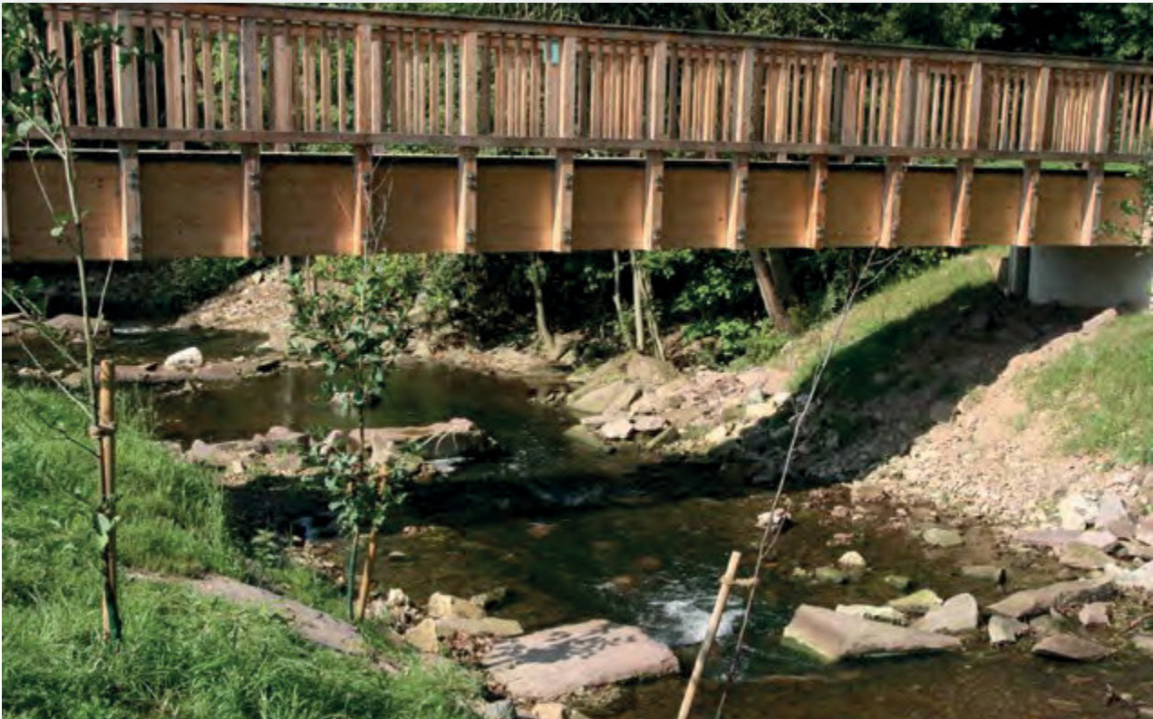
Fußgängerbrücke über die Lenne
