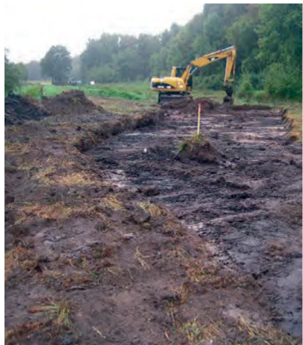
Anlage einer Sekundäraue
