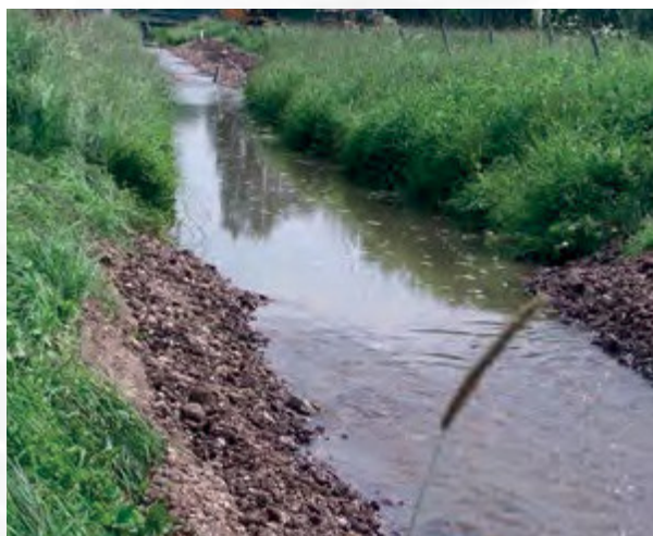
Neue Kiesbank unterhalb einer Gleite
