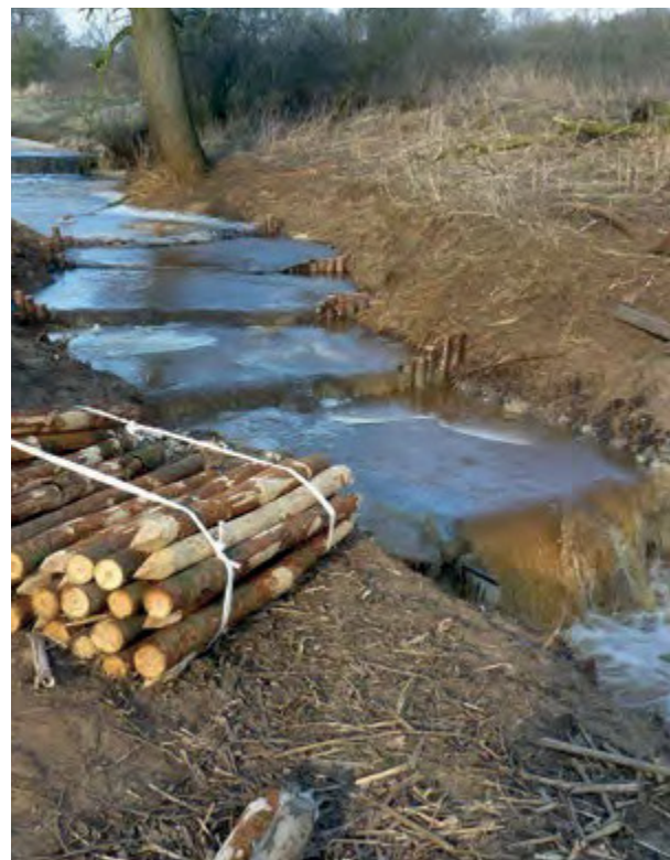
Abschnitt des Hakengrabens während der Maßnahmen­durchführung
