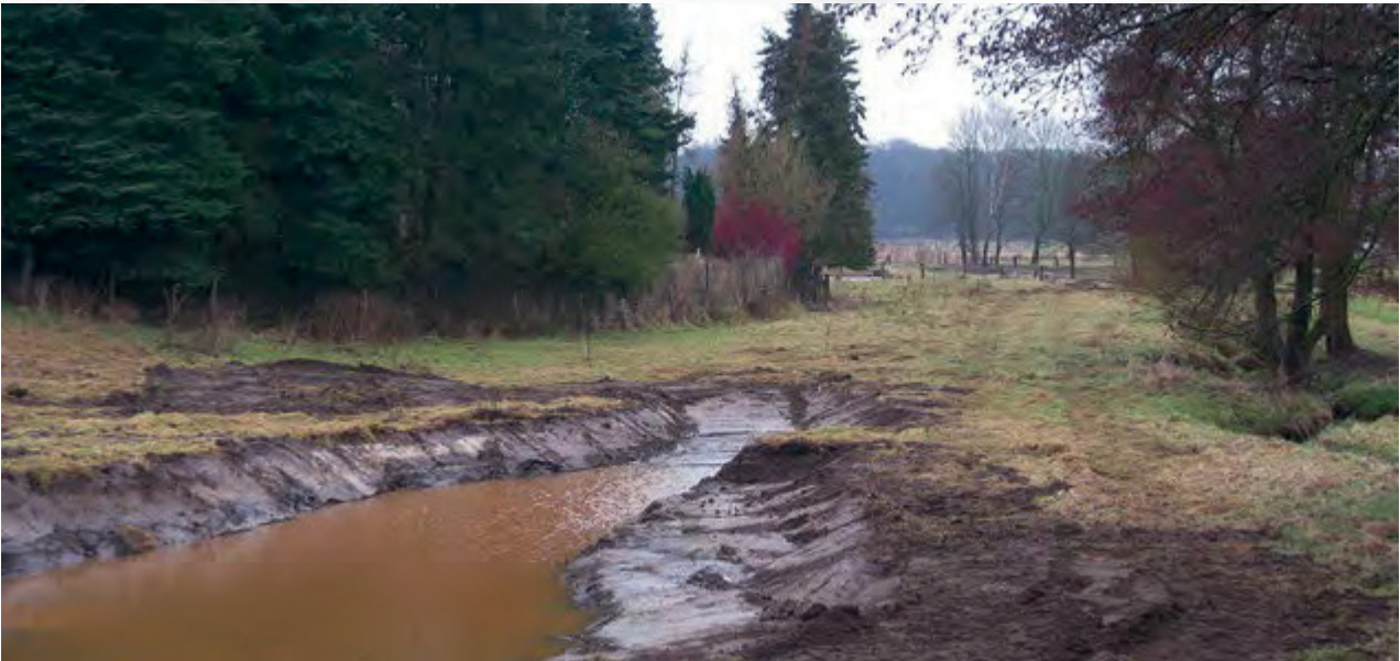
Während der Umsetzung der Maßnahmen
