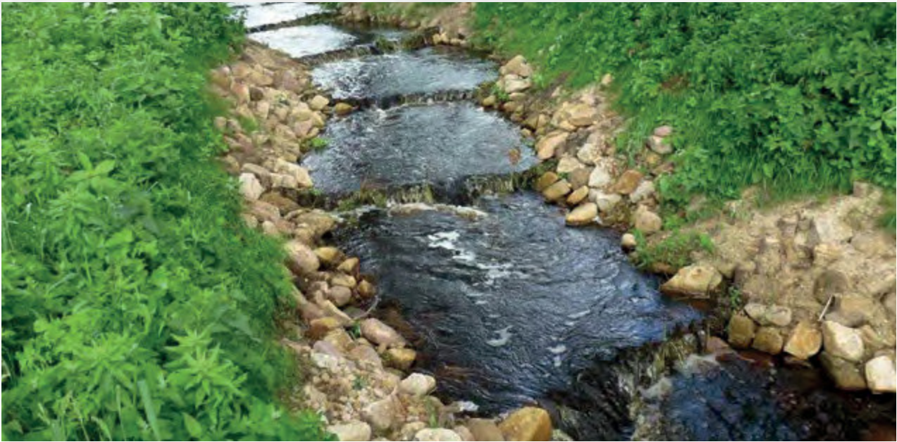
Hakengraben fertig gestellt
