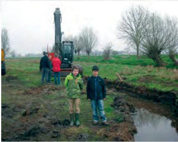
Während der Baumaßnahme ...
