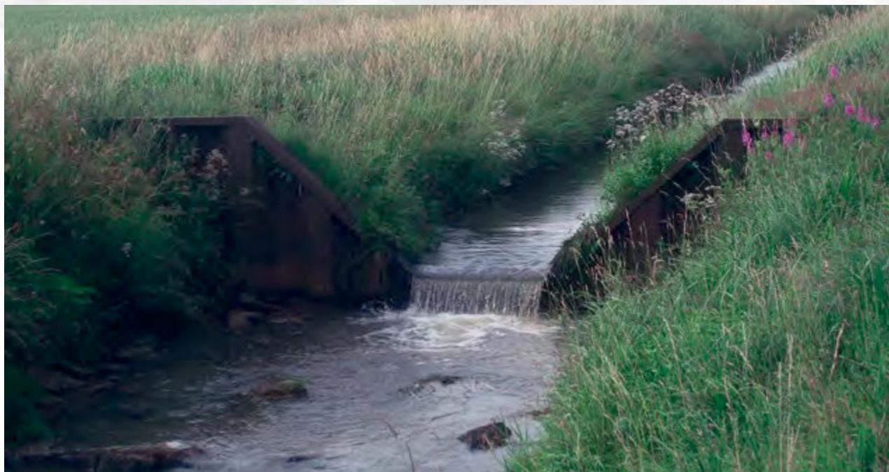
Der ehemalige Sohlabsturz am Dünsener Bach
