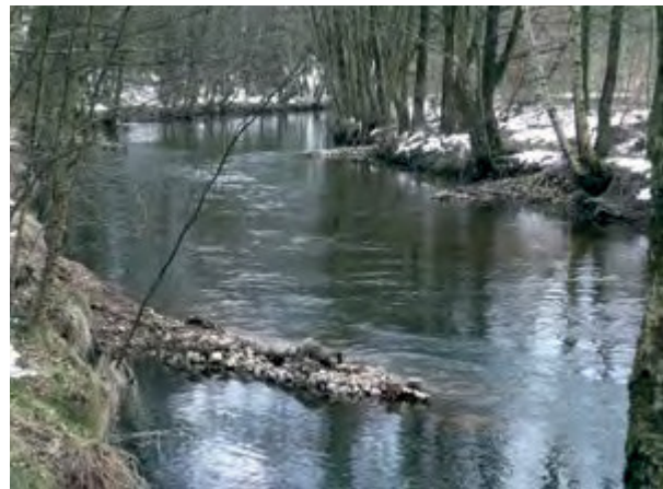
Buhnen nach der Maßnahme
