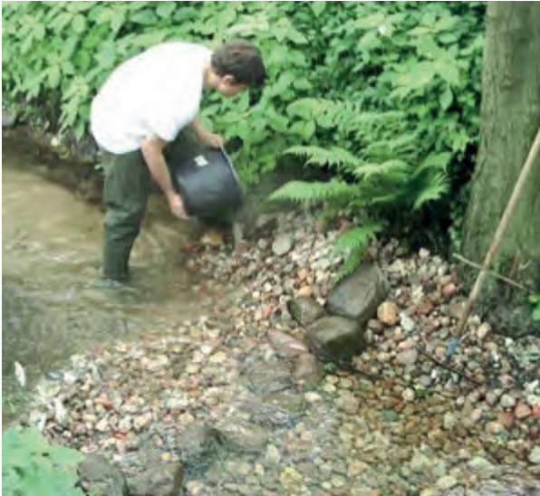
Strömungslenker und Kiesbetten wurden eingebaut
