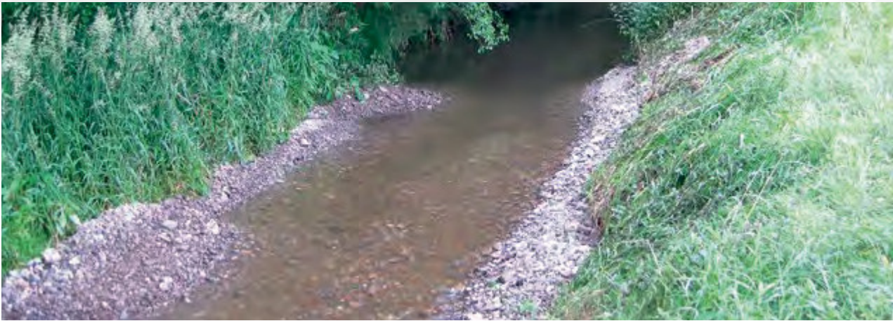
Abschnitt nach Maßnahmenumsetzung
