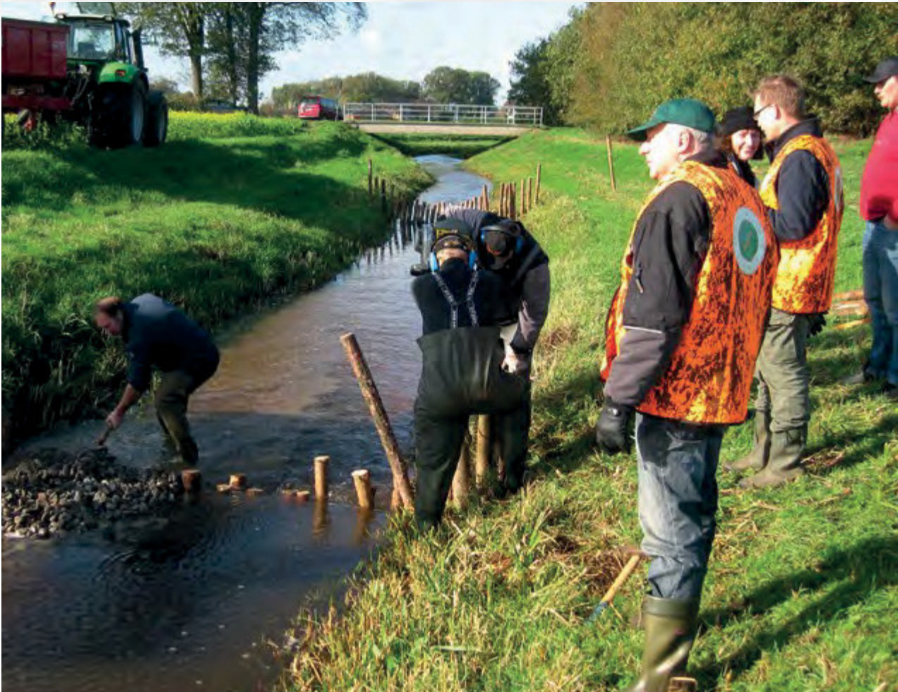
Einbau von Kiesbänken
