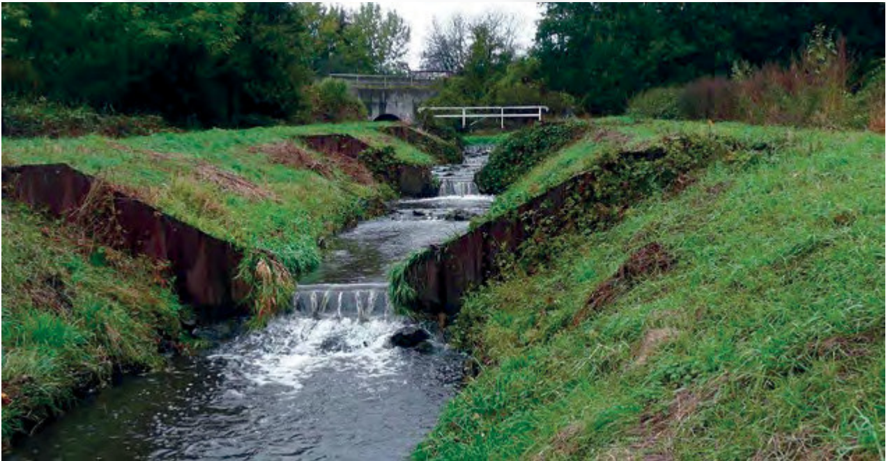
Scharmbecker Bach: Ausgangssituation 2011
