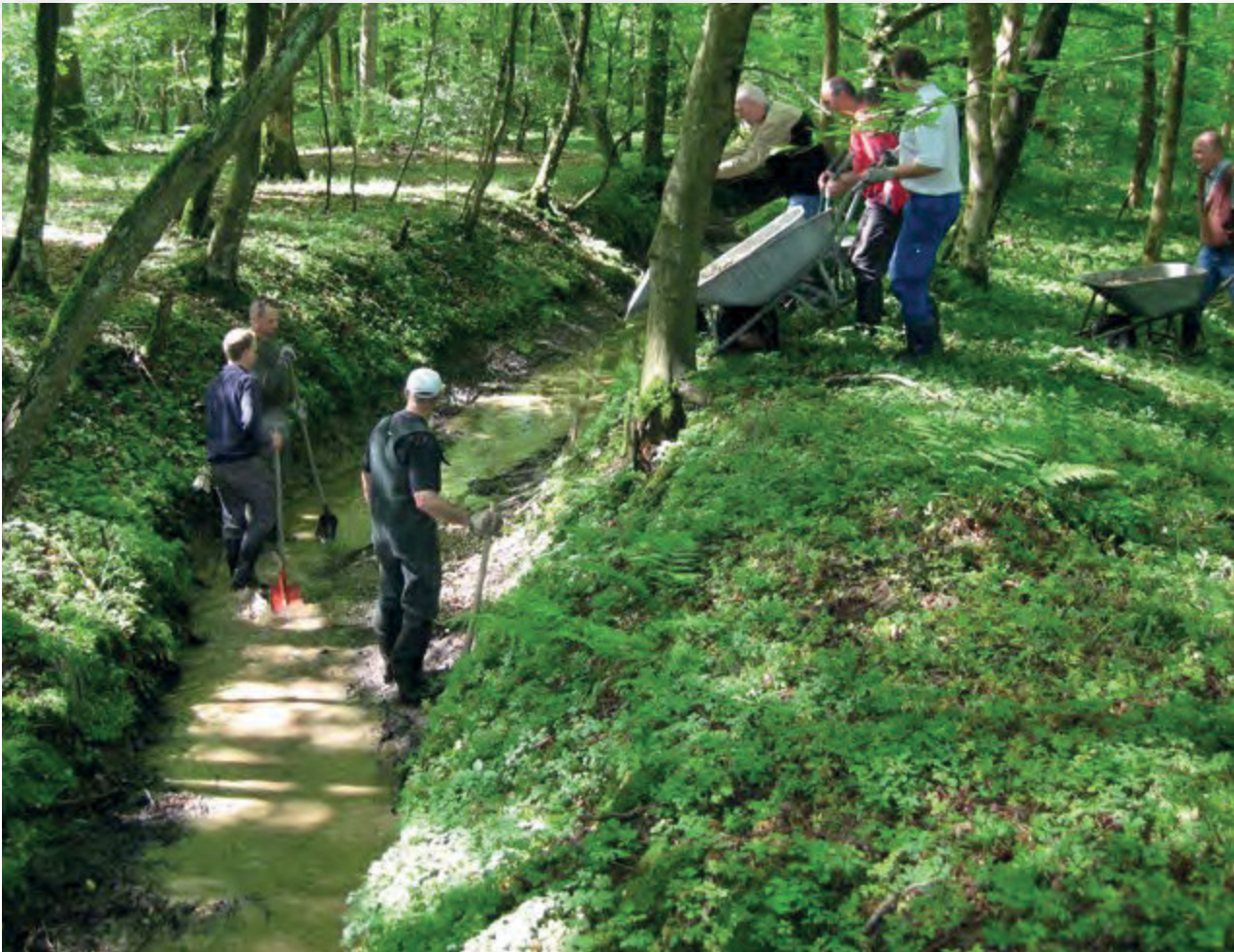
Kieseinbau im Lohriengraben
