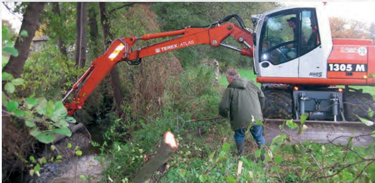
Maschinelle Einbringung von Kies in das Gewässer
