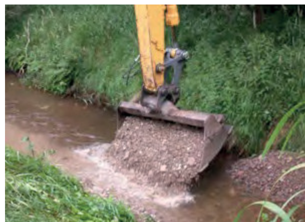
Neuanlage einer Kiesbank
