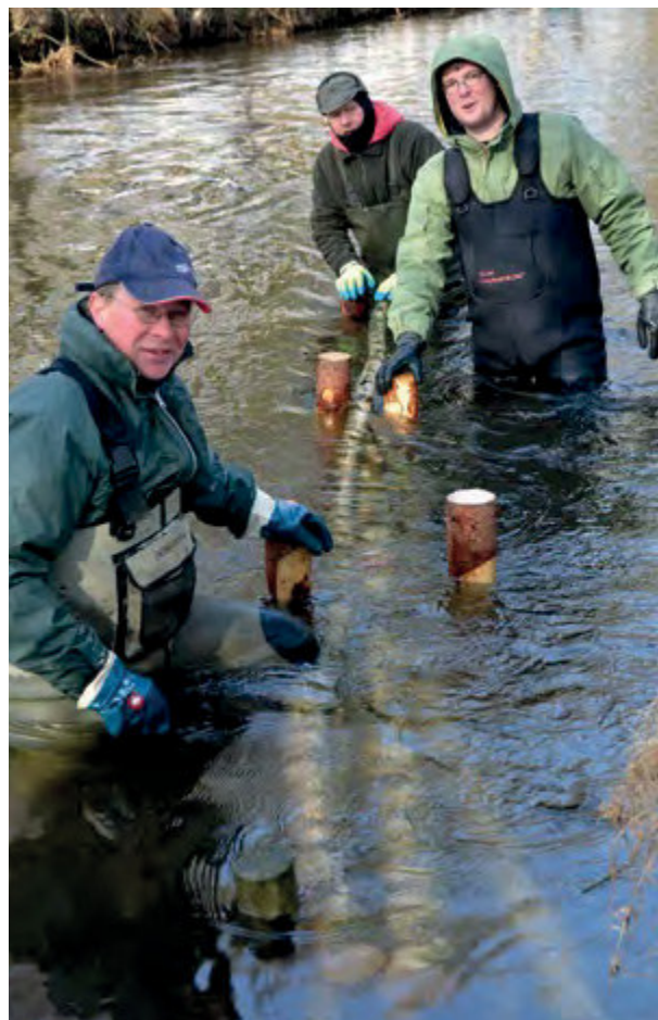
Holzkonstruktion im Aufbau
