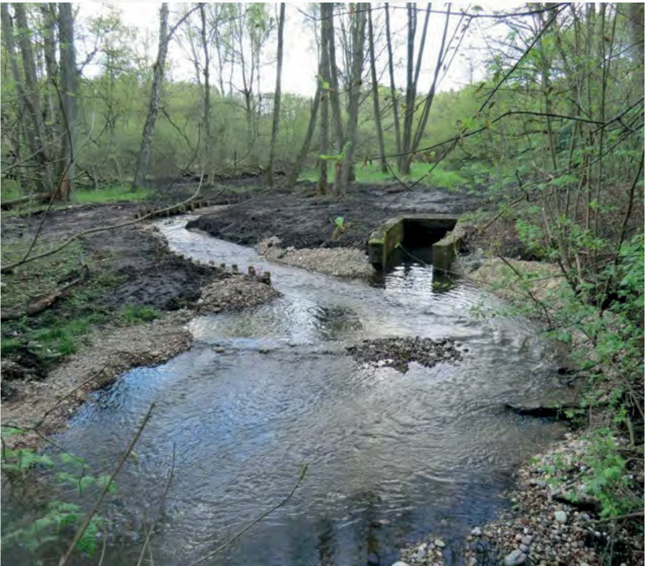
Geschwungenes Gerinne bei der ehemaligen Wehranlage 3
