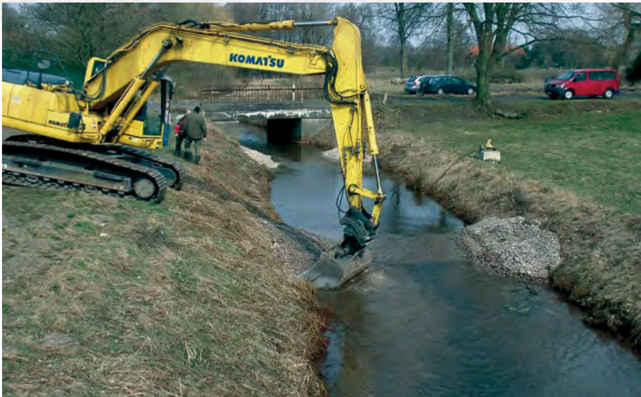
Einbau einer Kiesbank in der Riehe
