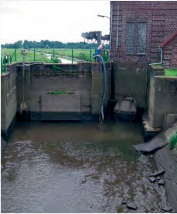
Basbecker Schleusenfleth - Druckkammer vor Maßnahmenbeginn
