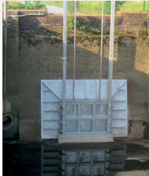
Hubschützanlage
