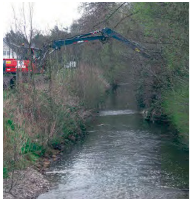
Während der Umbaumaßnahme
