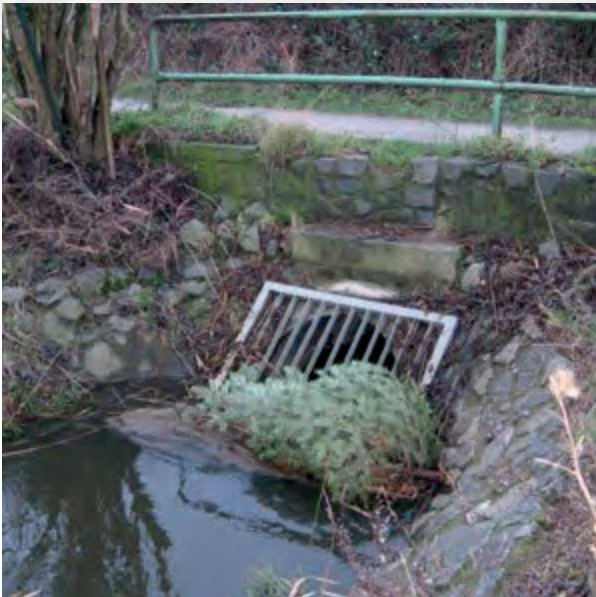
Einlauf in die Verrohrung vor der Maßnahme
