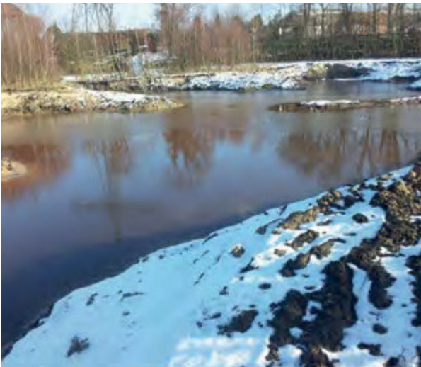
Lathener Beeke nach der Fertigstellung im Januar
