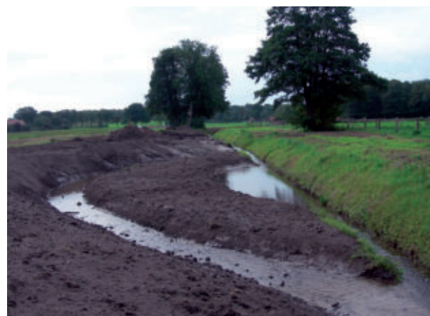
Endzustand kurz nach Fertigstellung
