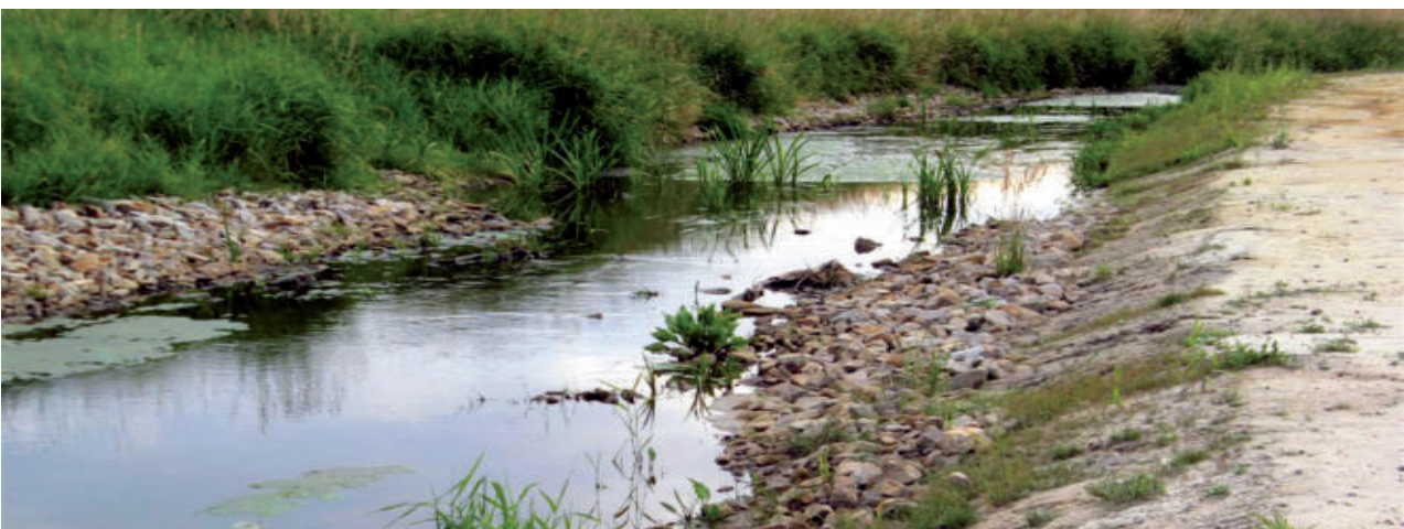
Schottersohlgleite mit Totholz
