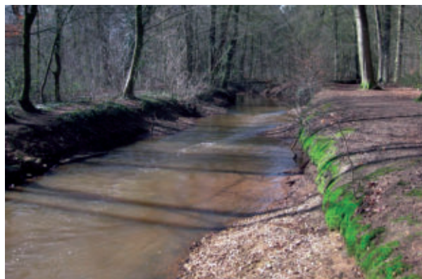
Die fertige Kiesbank dient künftig als Laichhabitat und zur Erhöhung der Strömungsdynamik. Bereits jetzt ist eine erhöhte Fließgeschwindigkeit der Welse erkennbar.
