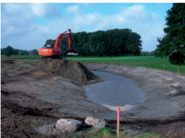
Baggerarbeiten am Amphibienteich
