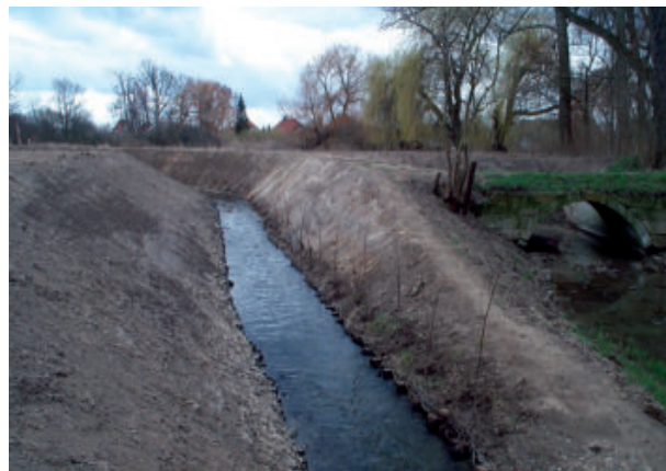
2006: Neuer Lauf nach Fertigstellung (Faschinen+ Erlenbepflanzung)
