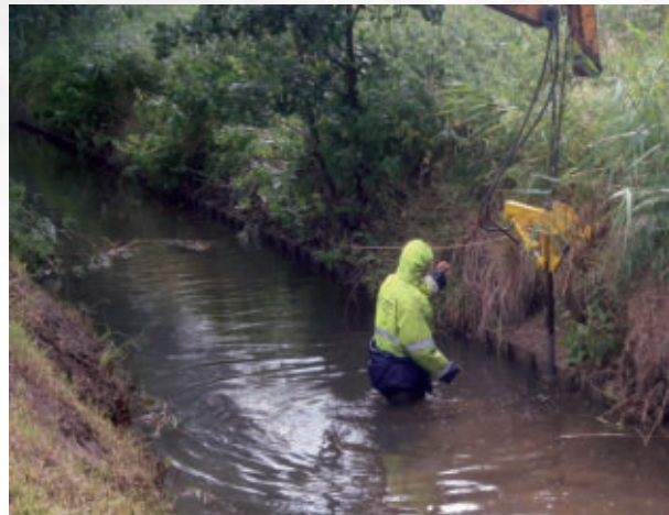
1. Schritt - Ausbau der Böschungfußsicherung
