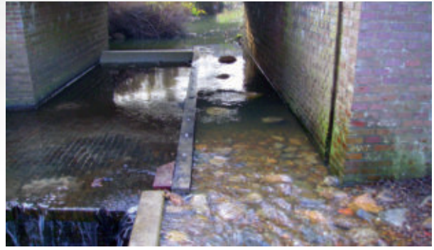
Der Mühlenabsturz nach der Renaturierung
