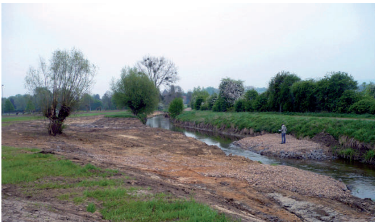
Nach Fertigstellung im Mai 2011 (Blick Richtung Osten)
