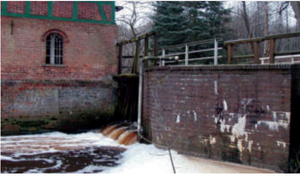
Vor der Maßnahme (Sohlabsturz)
