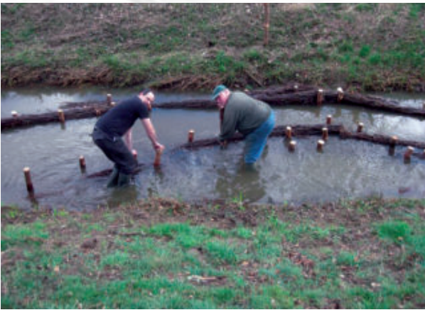
Faschineneinbau: Hier ist bereits der künftige Verlauf des Elsbaches erkennbar.
