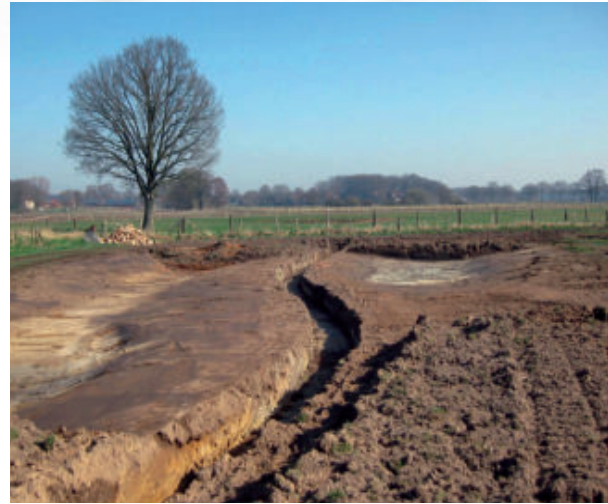
Das neue Bachbett mit seitlichen Flutmulden zur Hochwasserretention
