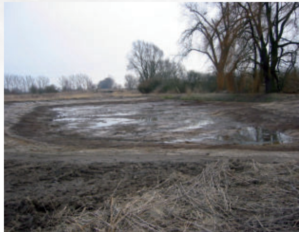
2006: Aushub der Senke zur Hochwasserrückhaltung
