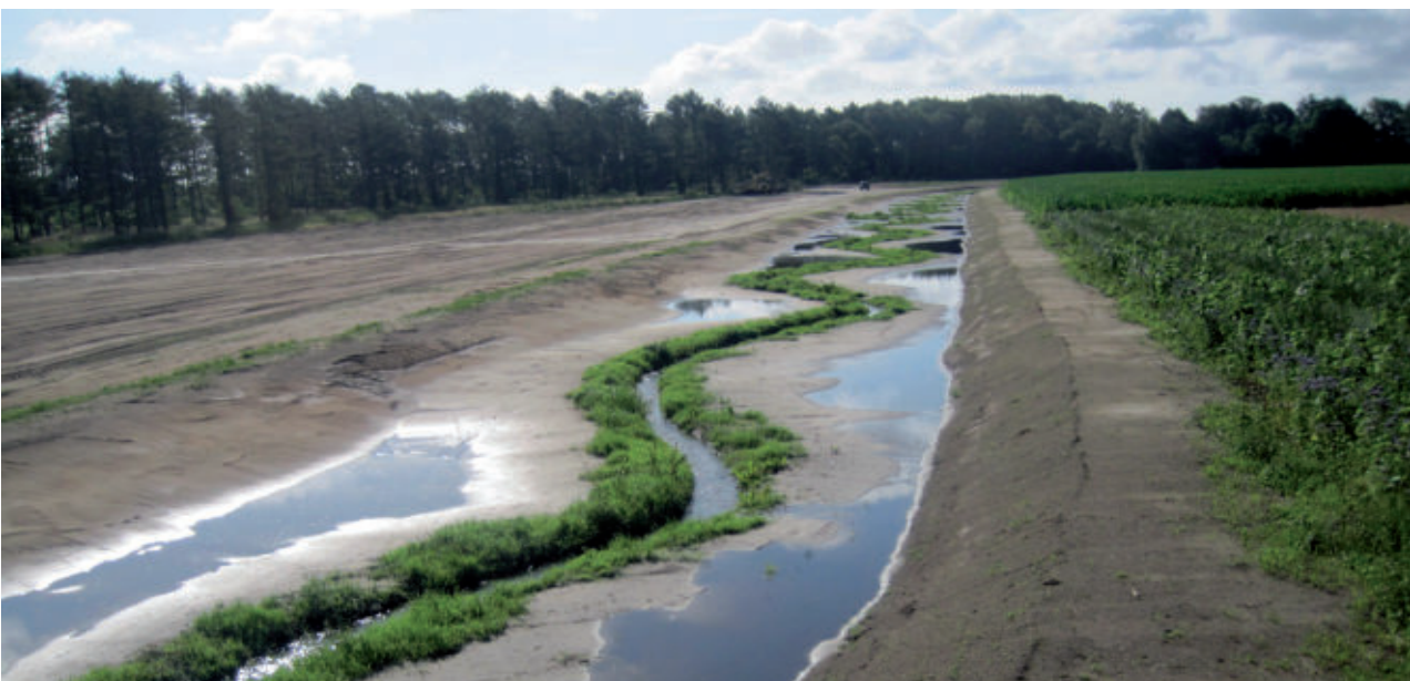
Nach dem Umbau: Ein geschwungener Bachlauf
