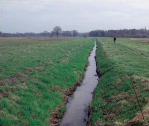
Vor der Maßnahme (gerades Trapezprofil)
