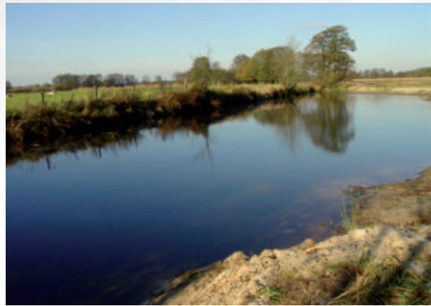
2005: Ausgebaggerter Altarm (Blick nach Norden)
