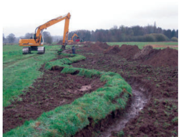
Ufersicherung durch Grassoden
