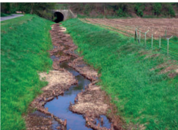
Die Maßnahme kurz nach der Fertigstellung. Die Wechselseitige Einengung des Gewässerbettes bewirkt ein Freispülen der Sohle.
