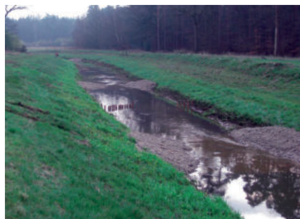
Die Eileringsbecke nach Fertigstellung der Maßnahme. Die Revitalisierung beschränkte sich auf den Gewässerlauf, da seitl. Flächen nicht zur Verfügung standen (1,2 km).
