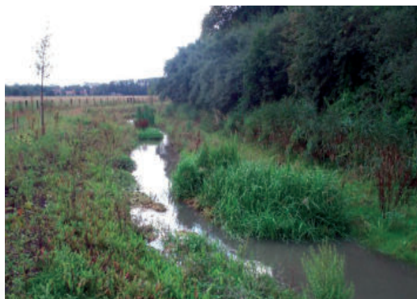
Abschnitt II nachher, flache Böschung und Verschwenkungen (2004)
