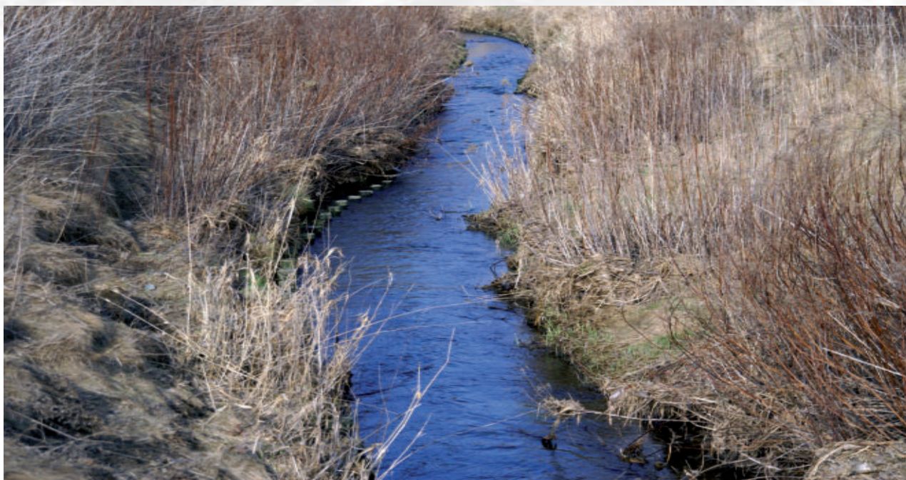
Neuer Fuhseabschnitt 2012: Leichte Mäandrierung ist deutlich erkennbar, die Faschinen werden bereits hinterspült.
