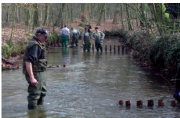
Einbau der Treibselfänger
