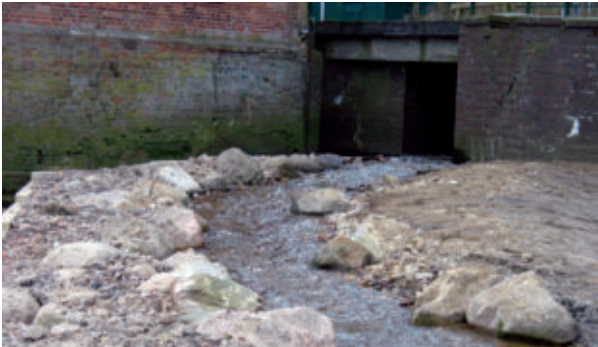
Blick auf Sohlgleite Richtung Oberlauf
