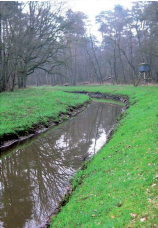
Die ausgebaute Eileringsbecke vor Beginn der Maßnahme
