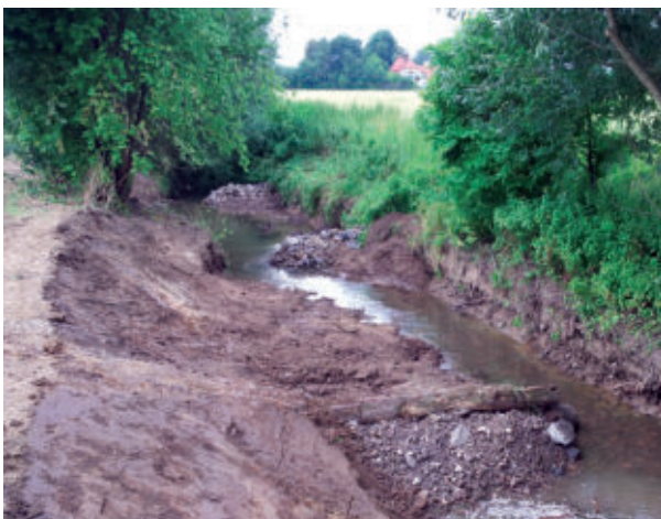
2. und 3. Schritt - Einbau von Strömunglenkern und Feuchtbermen
