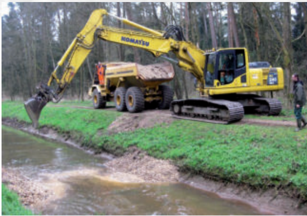
Einbau von Hartsubstrat in Form von Kiesbuhnen
