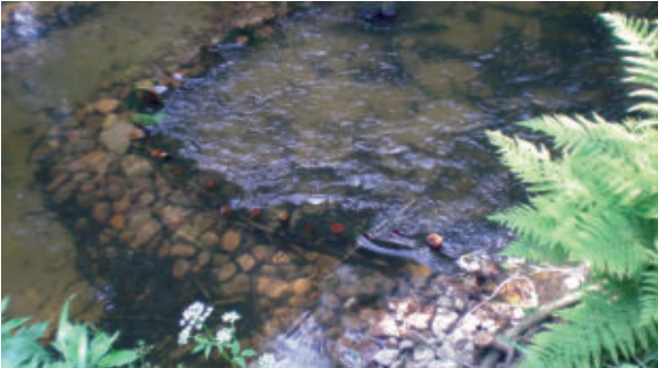
Einbau von Kartoffellosesteinen, mit Totholz fixiert
