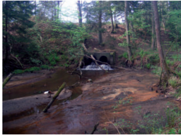
Ausgangszustand - Verrohrungsende mit Kolk unterhalb des Bahndamms
