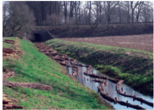
Auf einer Länge von 400 m wurden Faschinen eingebracht (Initiator für eine eigendynamische Gewässerentwicklung).
