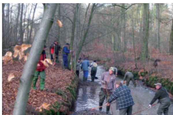
Kieseinbringung durch ehrenamtliche Helfer
