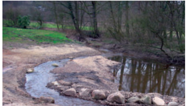
Blick auf Sohlgleite Richtung Unterlauf
