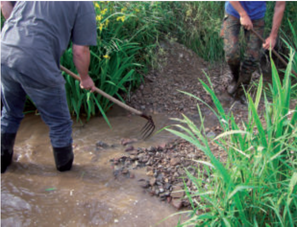
Einbau der Kiesbänke
