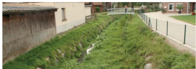
Berme in einer Ortschaft. Der eingengegte Mittelwasserabfluss linksseitig sorgt mit hoher Schleppkraft für eine freie Rinne und die Berme ist bei Hochwasser Retentionsfläche, um Abflussspitzen zu kappen.
