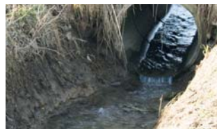
Die ursprüngliche Sohlage lässt sich am Durchlass erkennen. Durch zu tiefe Sedimententnahme entsteht ein Sohl sprung beim Durchlass, der die Durchgängigkeit verhindert und Sohle bzw. Ufer erodieren lässt. Ggf. kann die Grenze zum genehmigungspflichtigen Ausbau überschritten werden.
